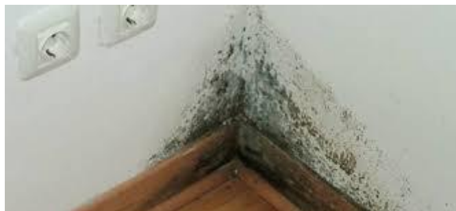
Slika 18. Gljivice u kući
