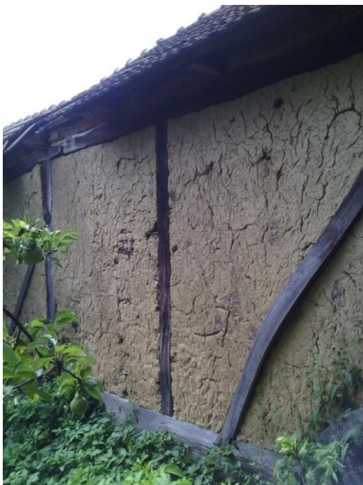
Slika 1. Zid stare zagorske kuće
