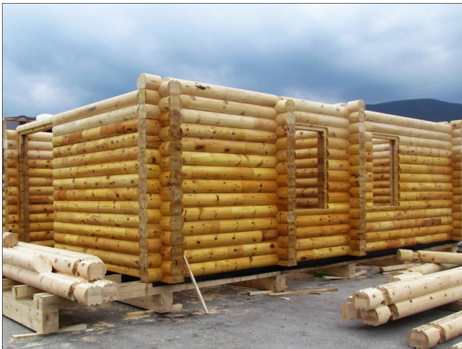
Slika 5. Primjer konstrukcije drvene kuće od trupaca
