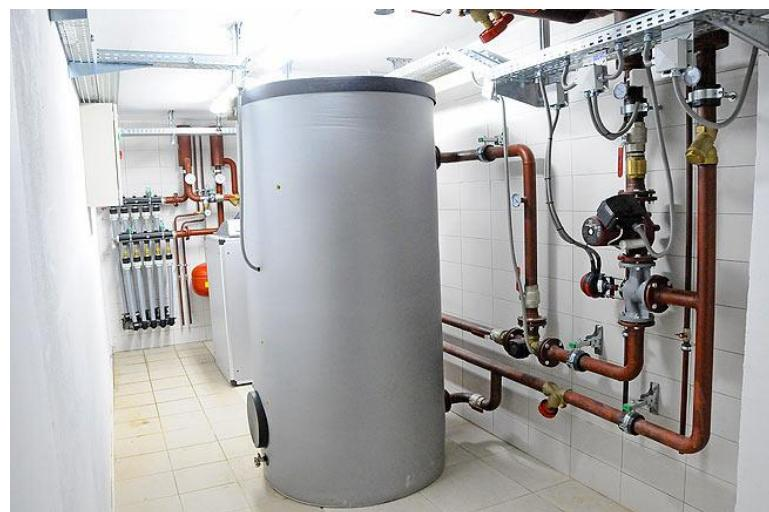
Slika 3.1.10. Sustav sa spremnikom, toplinskom pumpom i sondama
