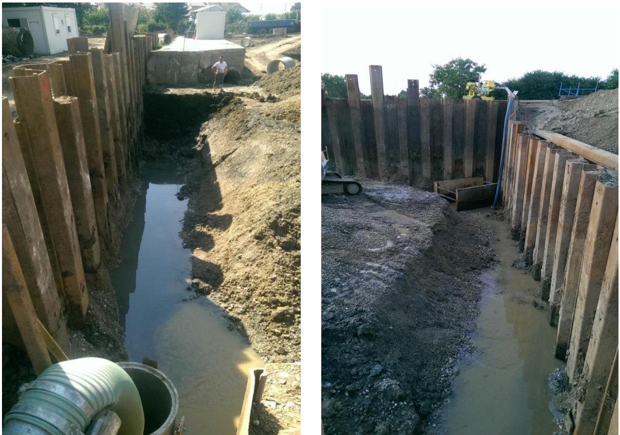
Slika 49. Voda u građevinskoj jami KP-II
