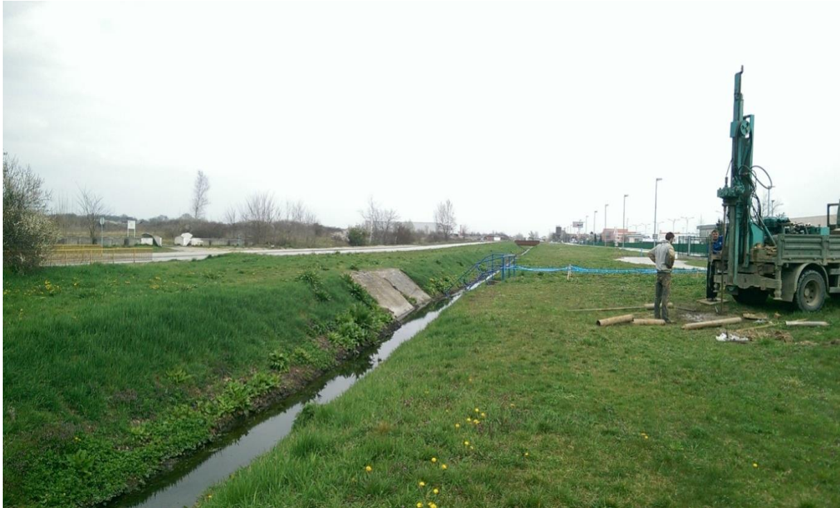
Slika 31. Lokacija kišnog preljeva KP-I
