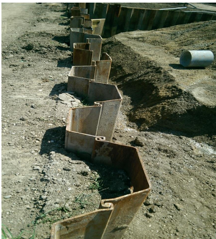
Slika 45. Postavljanje žmurja kontinuirano, jedan panel do drugog
