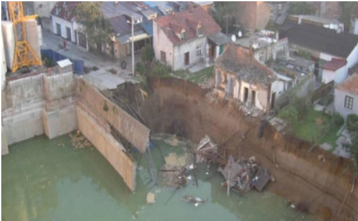
Slika 15. Posljedice hidrauličkog sloma tla u Kupskoj ulici
