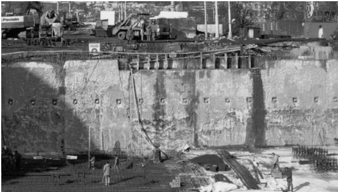
Slika 10. Armiranobetonska dijafragma
