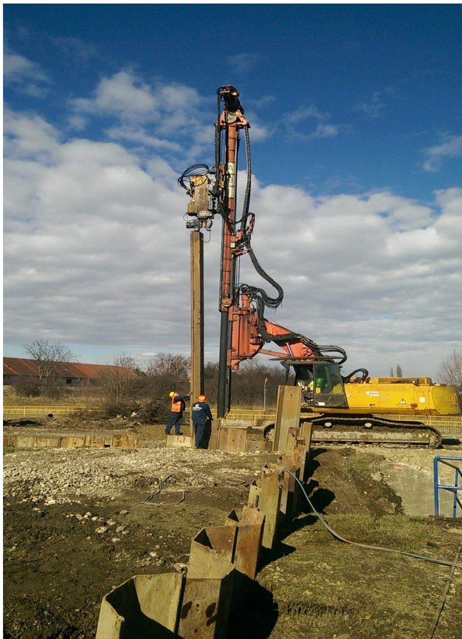
Slika 46. Ugradnja žmurja vibronabijačem
