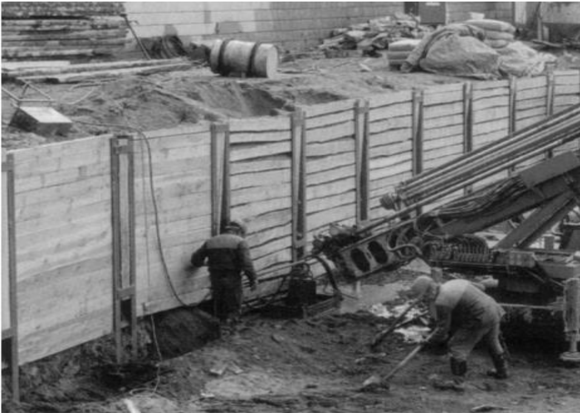
Slika 3. Berlinski zid od drvenih platice
