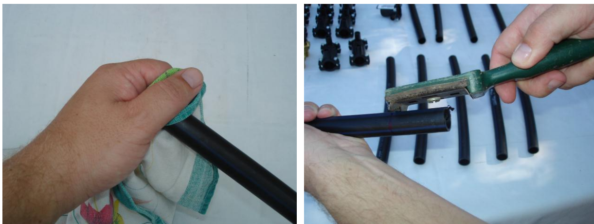
Slika 3.7. Priprema cijevi a) čišćenje cijevi od mehaničkih nečistoća b) ručno struganje krajeva cijevi [13]
