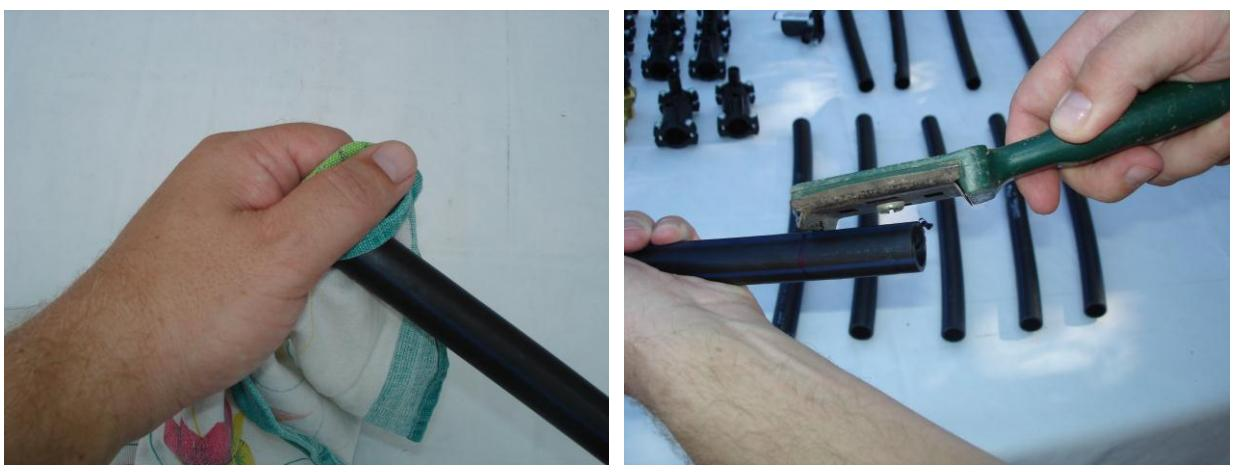
Slika 3.7. Priprema cijevi a) čišćenje cijevi od mehaničkih nečistoća b) ručno struganje krajeva cijevi [13]
