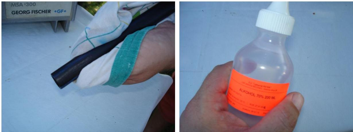
Slika 3.8. Priprema cijevi a) odmašćivanje cijevi krpom b) medicinski alkohol [13]
