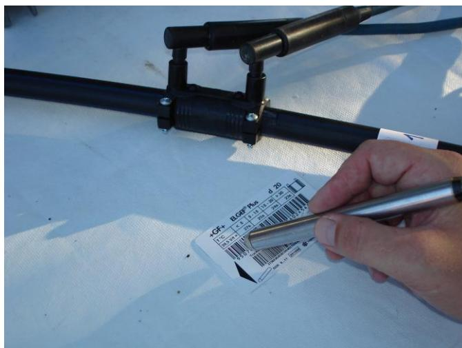
Slika 3.19. Očitanje barkoda sa magnetske kartice kod zavarivanja prvog uzorka [13]
