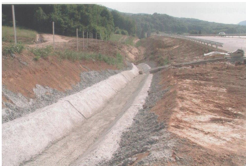
Slika 2. Trapezni odvodni jarak
