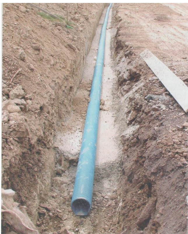
Slika 11. Plastična drenažna cijev na podlozi od betona
