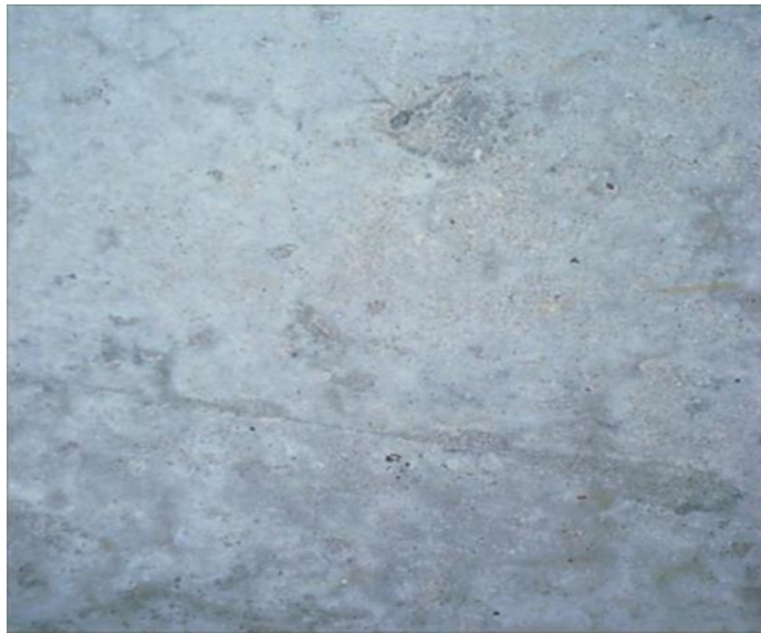
Slika 3.13. Pojava mikropukotina
