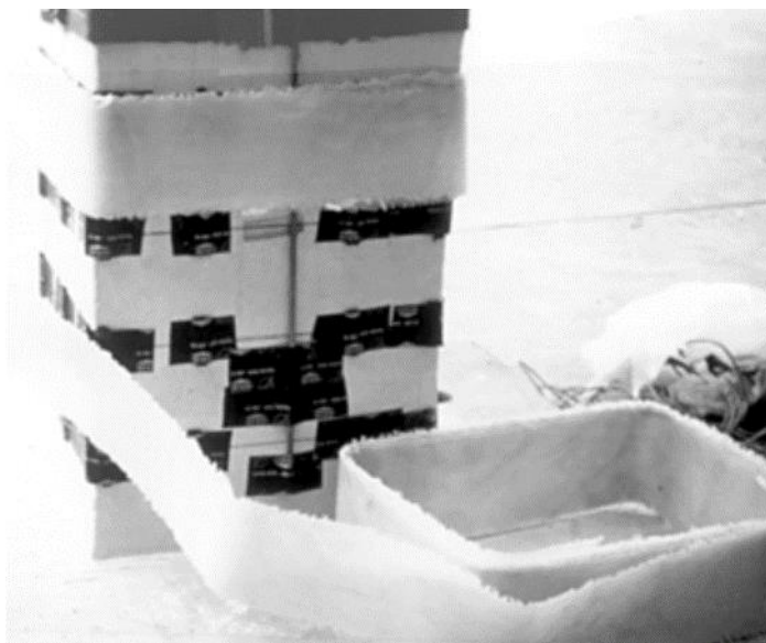
Slika 4.19. Omotavanje kontinuiranog FRP kompozitnog prstena u mnoštvo slojeva oko oštećene zone stupa
