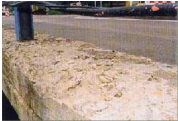
Slika 3.3. Primjeri oštećenja prilikom smrzavanja i odmrzavanja
