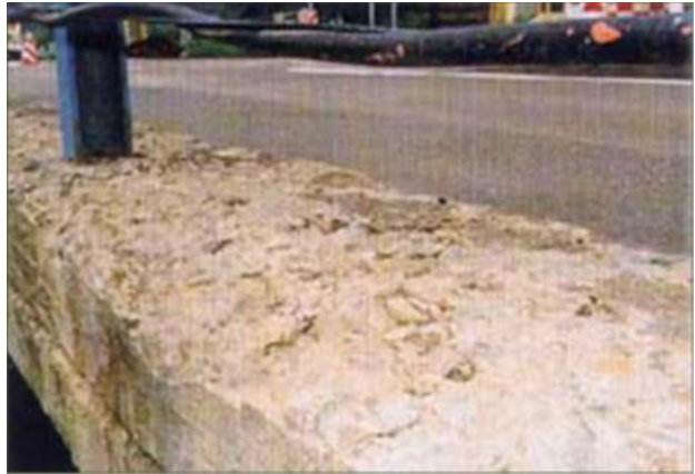
Slika 3.3. Primjeri oštećenja prilikom smrzavanja i odmrzavanja
