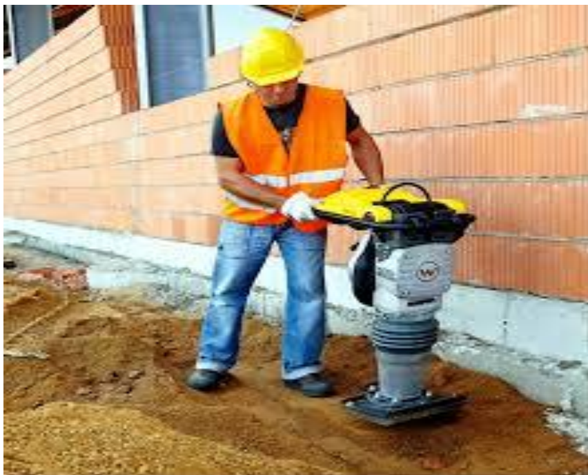
Slika 20. Vibro nabijač za zbijanje oko gotovih građevina
