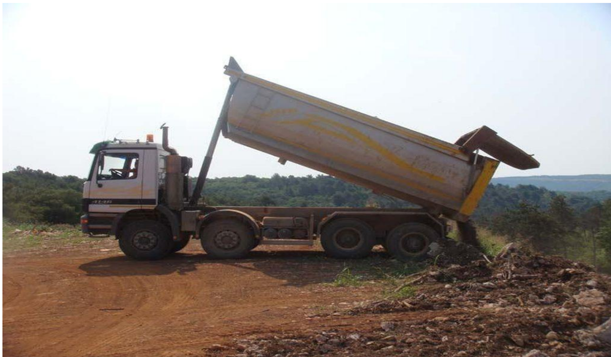
Slika 8. Istovar prevezene zemlje
