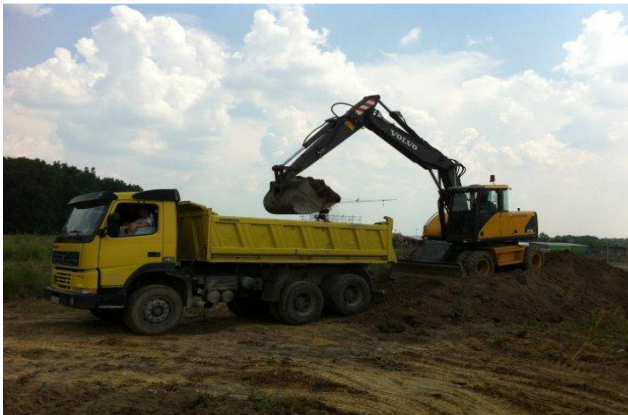
Slika 7. Utovar zemlje bagerom u kamion kiper
