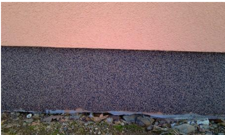
Slika 8. Sokl sa mozaik žbukom
