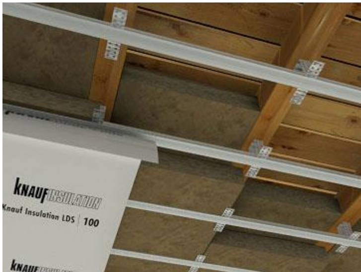
Slika 11. Izvedba kosog krova sa mineralnom vunom
