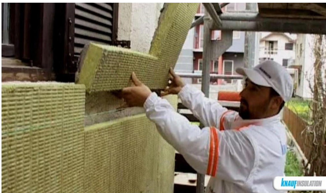
Slika 10. Postavljanje kamene vune oko prozora
