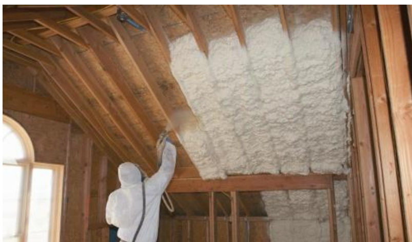
Slika 12. Izvedba termoizolacije krova sa poliuretanskom pjenom
