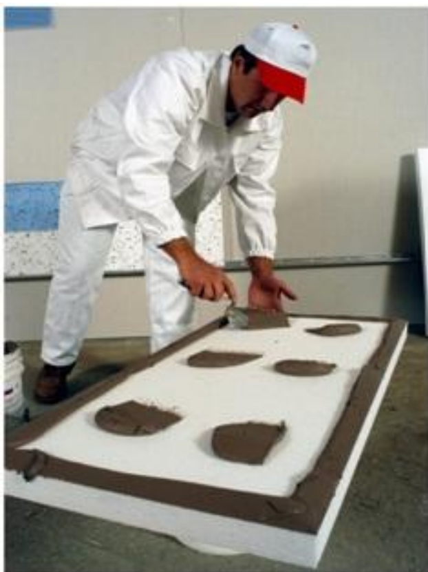
Slika 7. Nanošenje ljepila na stiropor ploču
