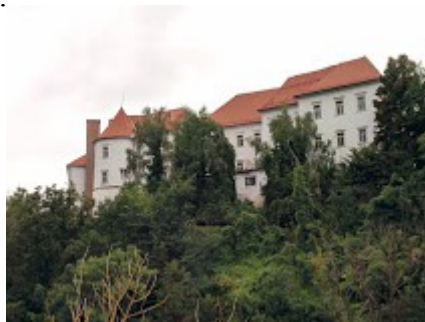
slika 4.1 Zavod Hrastovec – Trate(2)
