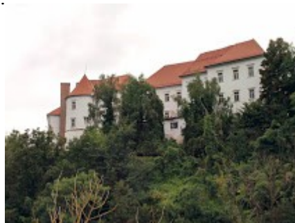
slika 4.1 Zavod Hrastovec – Trate(2)
