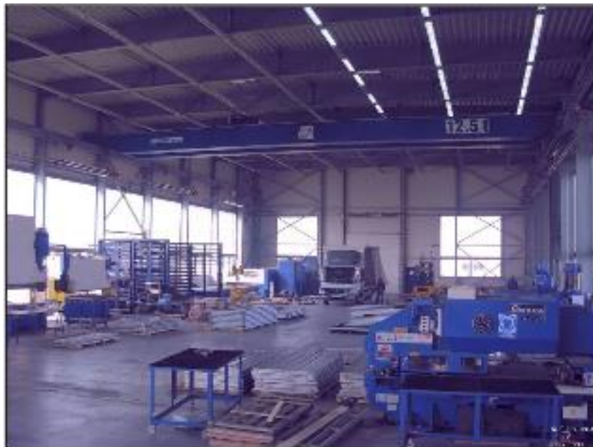
Slika 4.21.b) Unutrašnjost hale (pogled na drugu stranu)
