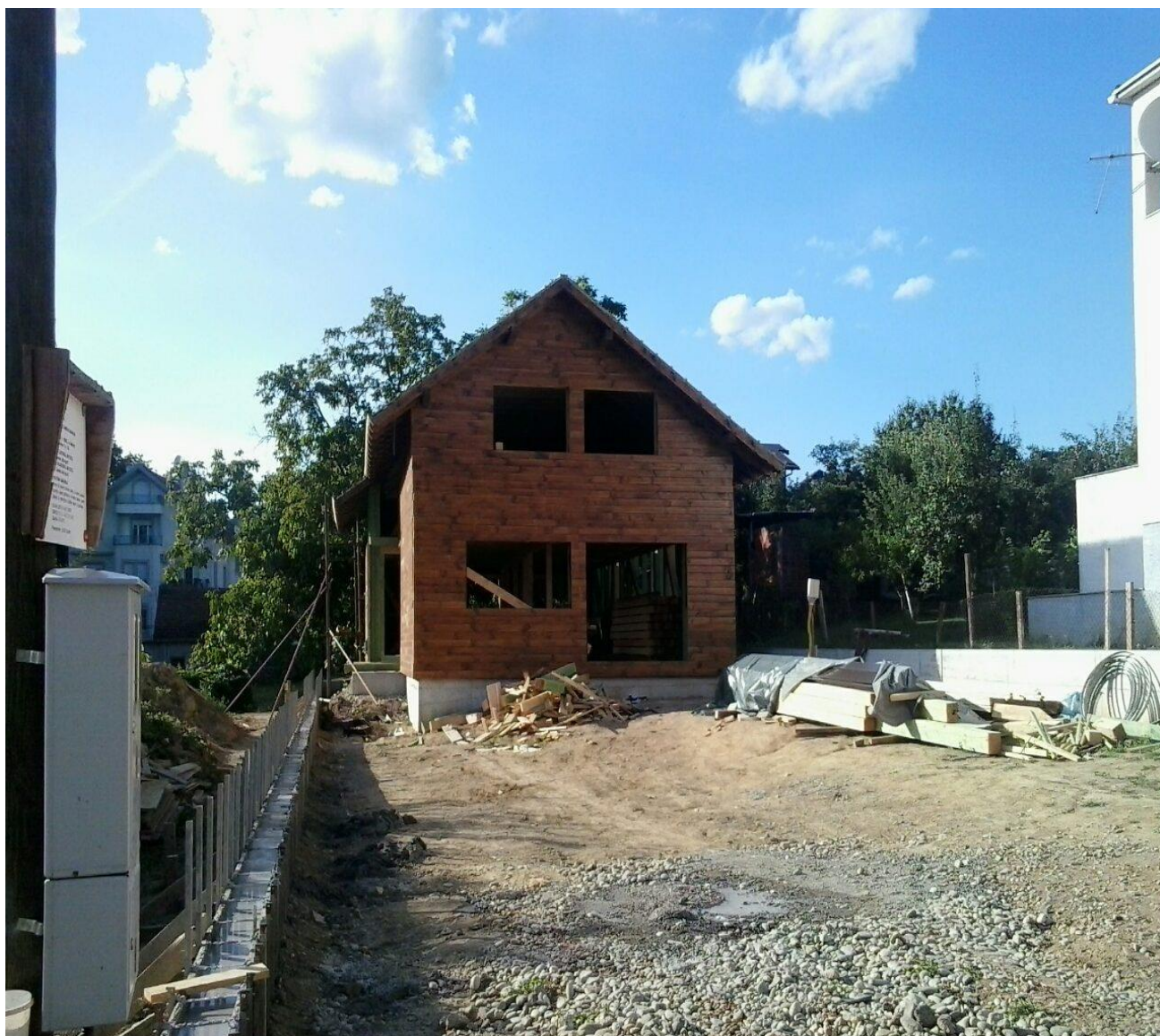
Slika 6.6 Betonirani ogradni zidovi parcele
