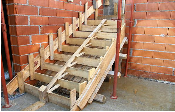
Slika 3.4.1. Izrada oplate za stubište
