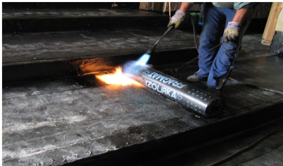
Slika 3.5. Prikaz postave horizontalne hidroizolacije, varenje ljepenke V3
