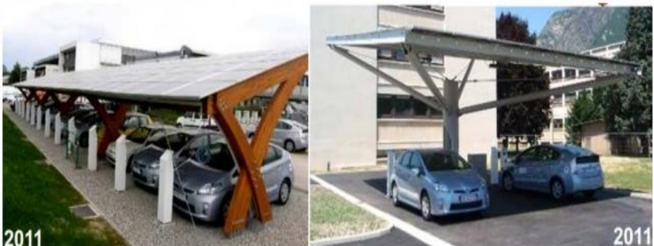
Slika 2.10. Punionice koje koriste električnu energiju proizvedenu u fotonaponskim panelima [19]
