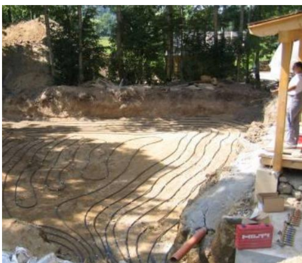
Slika 4.4.2.1. Zemni kolektor pasivne kuće u Begovom Razdolju (2007)
