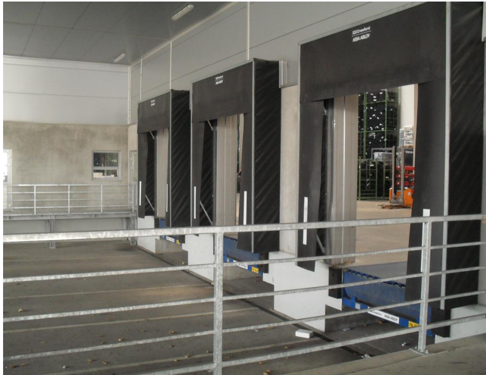
Slika 4.3. : Utovarno-istovarne rampe
