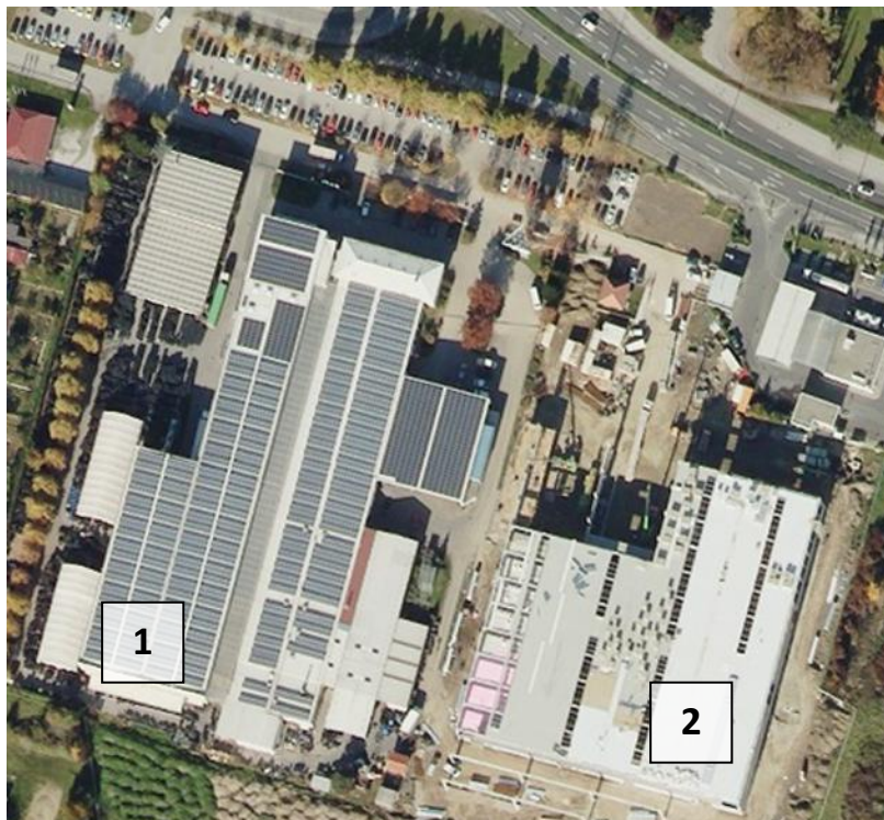
Slika 4.1. : Gumiimpex iz zraka; 1. zgrada uprave, prodaje i proizvodnje; 2. skladište gotovih proizvoda
