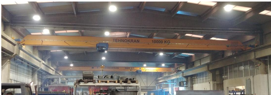
Slika 4. Kranovi u zavarivačkoj radionici
