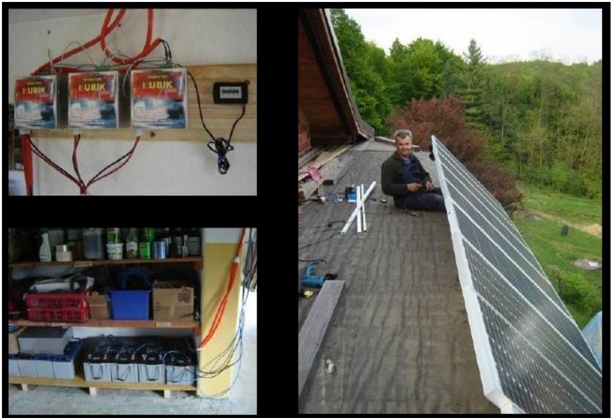
Slika 27 Postavljanje solarnih panela
