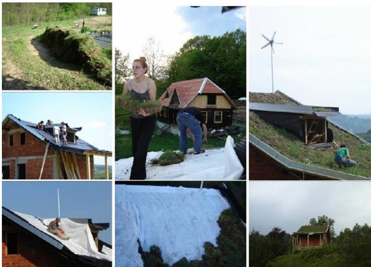
Slika 29 Postavljanje zelenog krova
