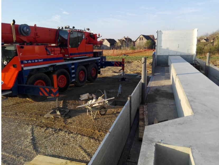
Slika 4.6. Doprema AB stupa na kamionu
