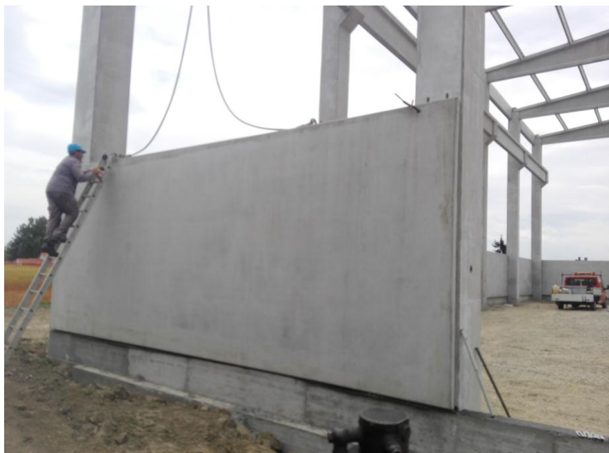
Slika 4.17. AB troslojni fasadni panel na mjestu pozicije montiranja
