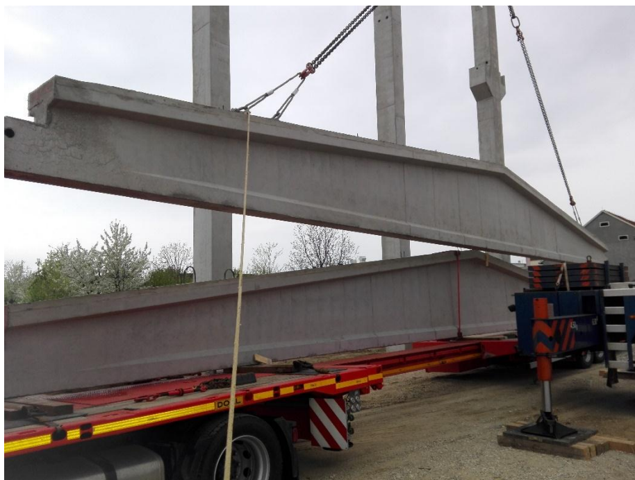
Slika 4.10. Doprema glavnog krovnog gednog nosača te montiranje istog
