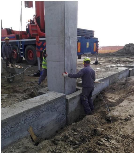
Slika 4.8. Postavljanje AB stupa u temeljnu čašu
