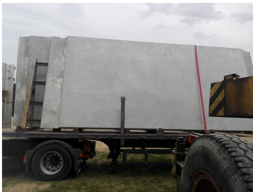
Slika 4.16. AB troslojni fasadni paneli na kamionu
