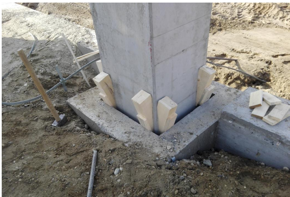
Slika 4.9. Centriranje AB stupa po vertikalnoj osi pomoću drvenih klinova
