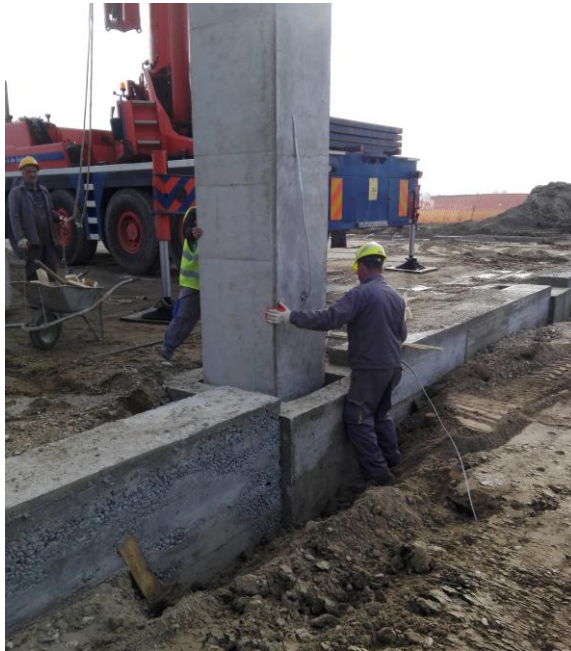
Slika 4.8. Postavljanje AB stupa u temeljnu čašu
