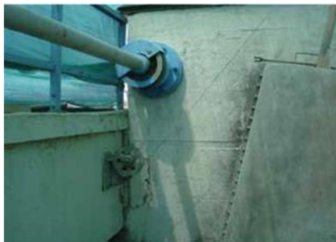
Slika 2.10. Dijelovi sustava za kontrolu zakošenja [1]
