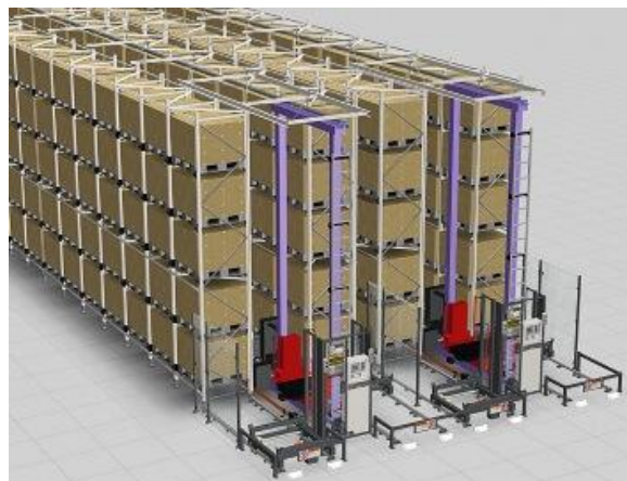
Slika 3.4. Automatizirano visoko regalno skladište ( Unit-Load AS/RS) [31]
