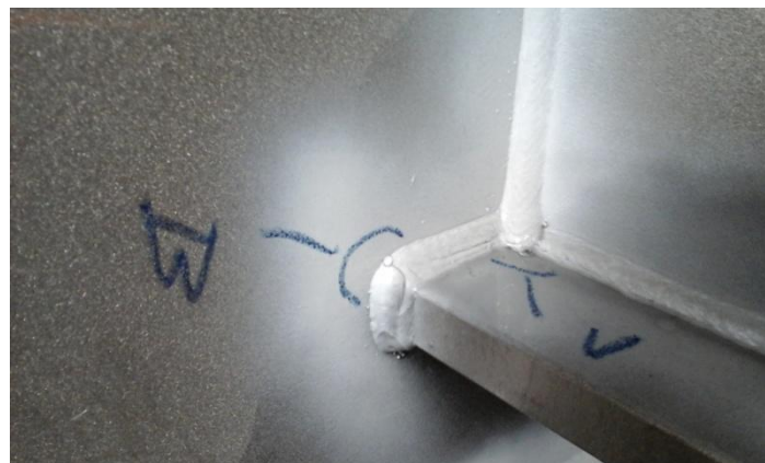
Slika 4.2.3 Navar (desno - oznaka V) zbog premalog unosa topline i neobrađeni završetak zavar ( lijevo – oznaka B)
