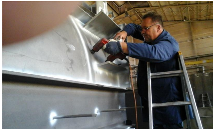
Slika 4.1.6 Nanošenje suspenzije i kontrola zavara
