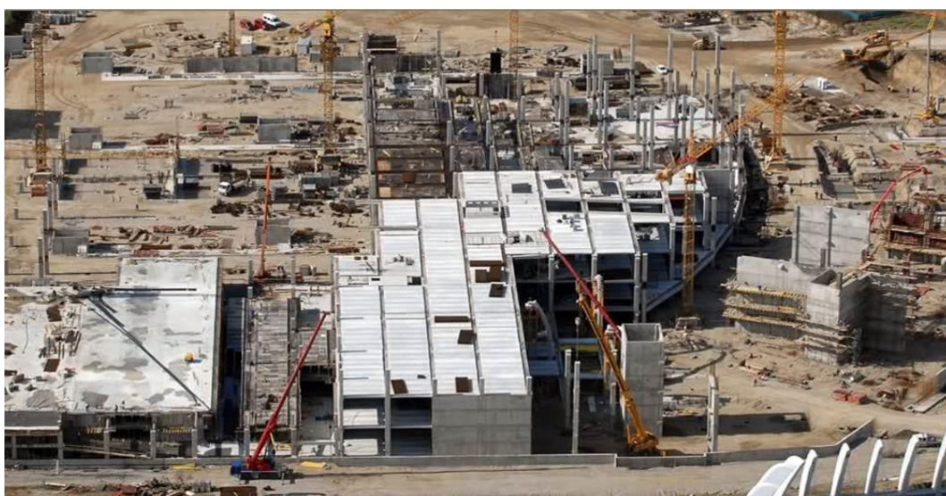
Slika 3.3. Izvođenje, lijevo PT monolit, desno montaža
