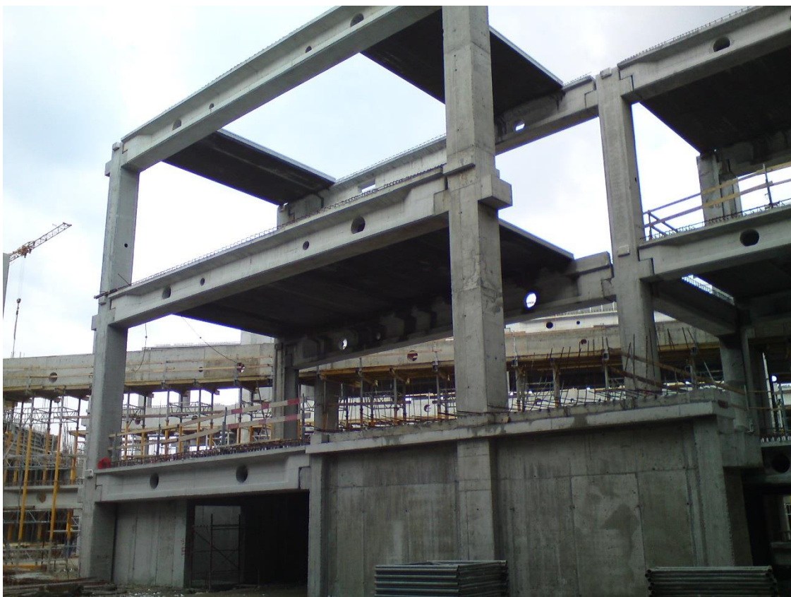
Slika 3.5. - Izgradnja stropne konstrukcije – Arena Zagreb
