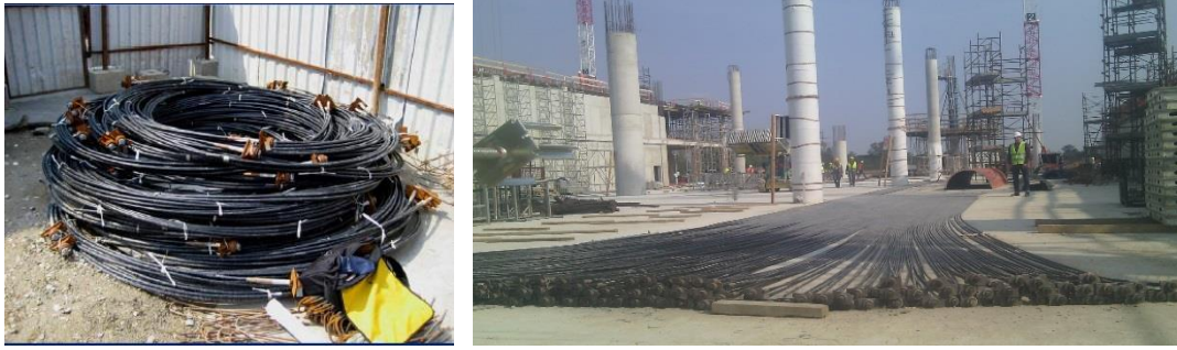
Slika 2.2.2. i 3. - Kablovi za naknadno prednapinjanje, priprema istih na gradilištu
