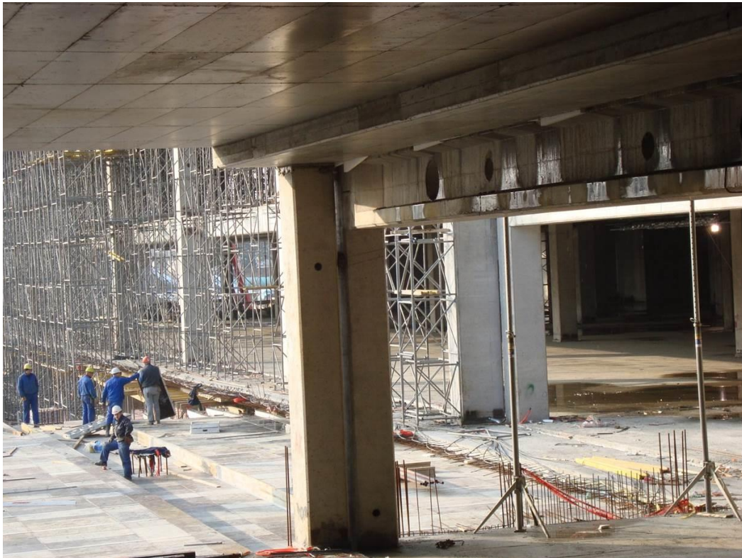
Slika 3.4. - Dodir dilatacija dviju koncepcija. PT varijanta ima visinu plitke grede 55 cm, a montažni dio ukupno 130 cm
