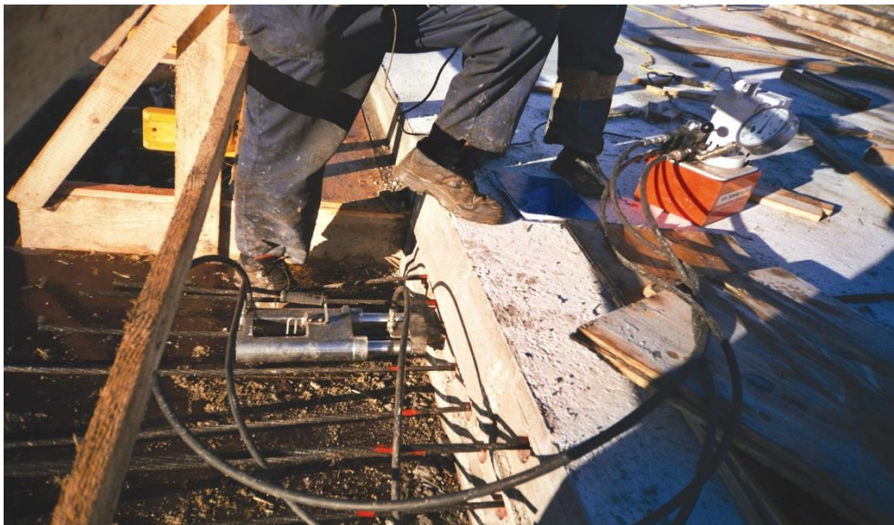
Slika 2.2.4. - Unos sile hidrauličkom prešom na silu od 223. KN (crvena markacija za izduženja)
