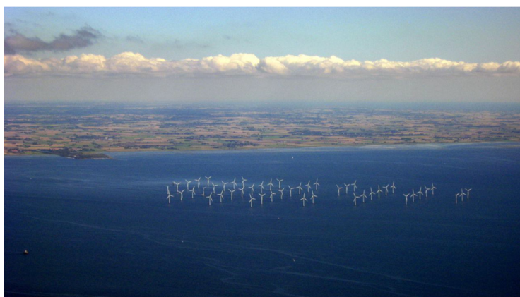
Slika 4.10 Priobalna vjetroelektrana Lillgrund [23]
