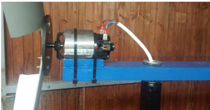
Slika 5.17 Montiranje generatora i postavljanje kabela
