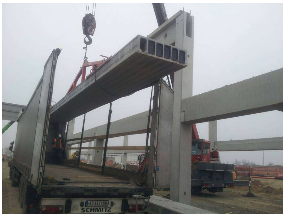
Slika 4.3. Podizanje prednapregnutih ploča
