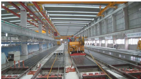
Slika 3.4. Prikaz strojno istiskivanje betonske mješavine
