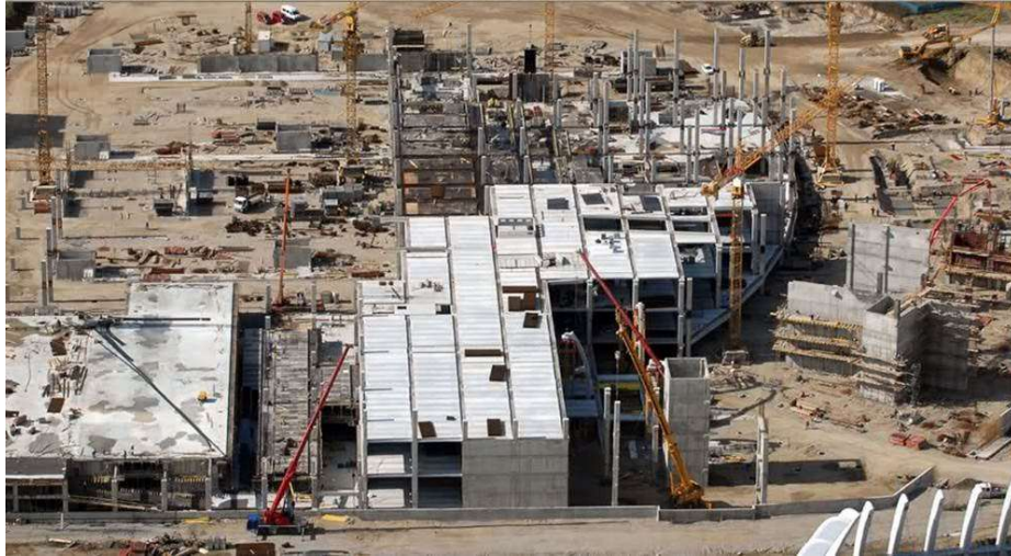
Slika 6.2. Panoramski pogled na gradilište ARENA CENTAR
