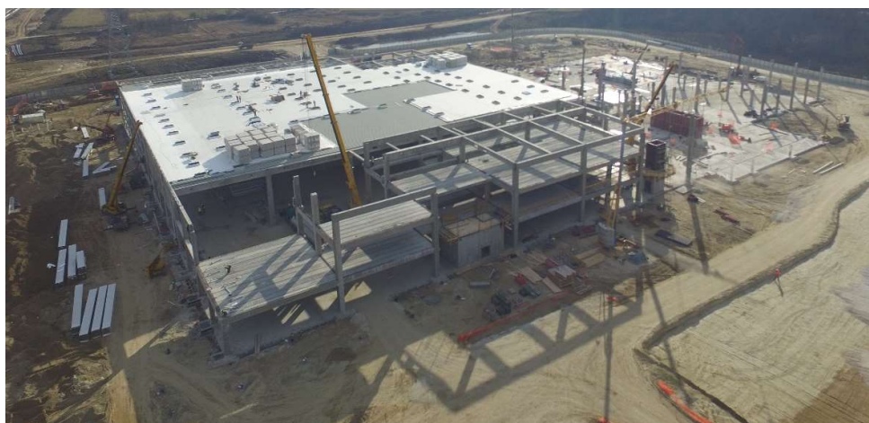
Slika 6.9. Panoramski pogled na gradilište IKEA
