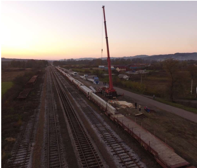
Slika 6.10. Prikaz utovara ploča na vlak
