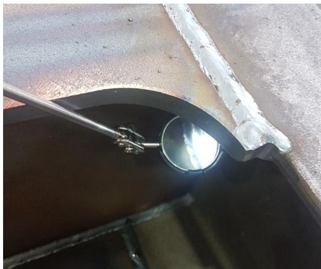
Slika 33. Vizualna kontrola zavarenog spoja
