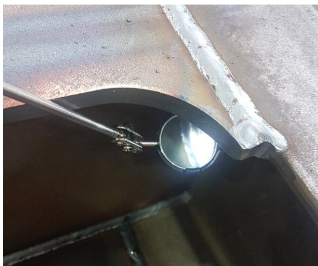
Slika 33. Vizualna kontrola zavarenog spoja
