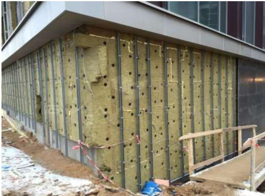
Slika 38. Postavljanje izolacije ispod ploča ventilirane kamene fasade
