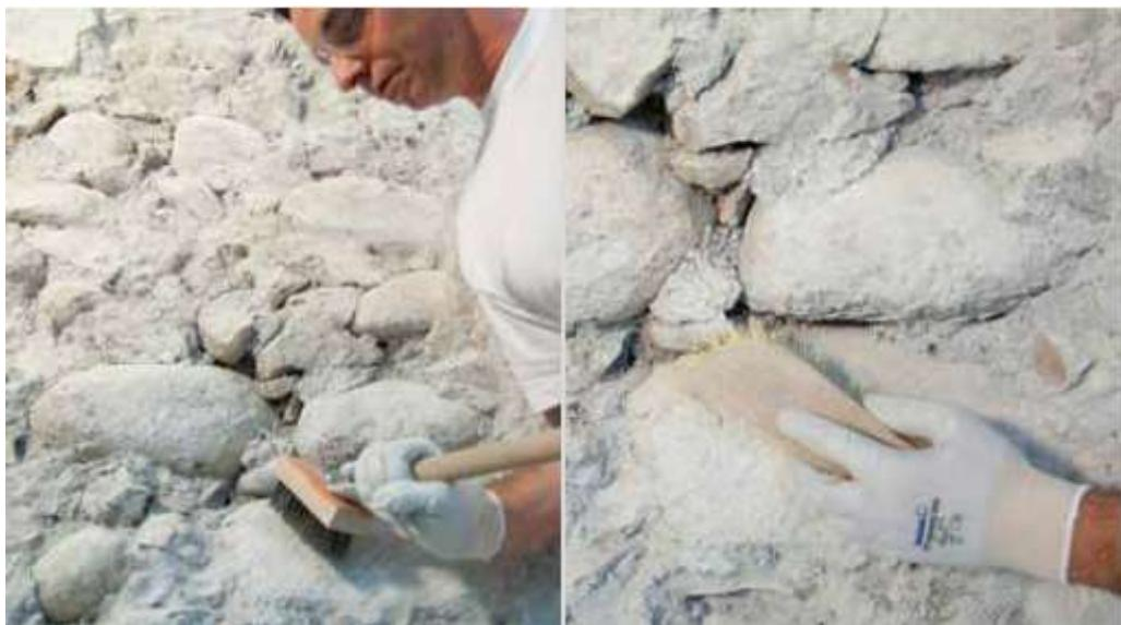
Slika 20. Ručno čišćenje kamenog zida četkom
