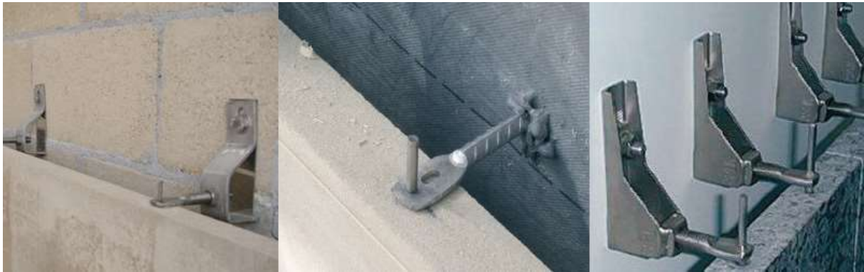
Slika 32. Kamena ploča učvršćena sidrima
