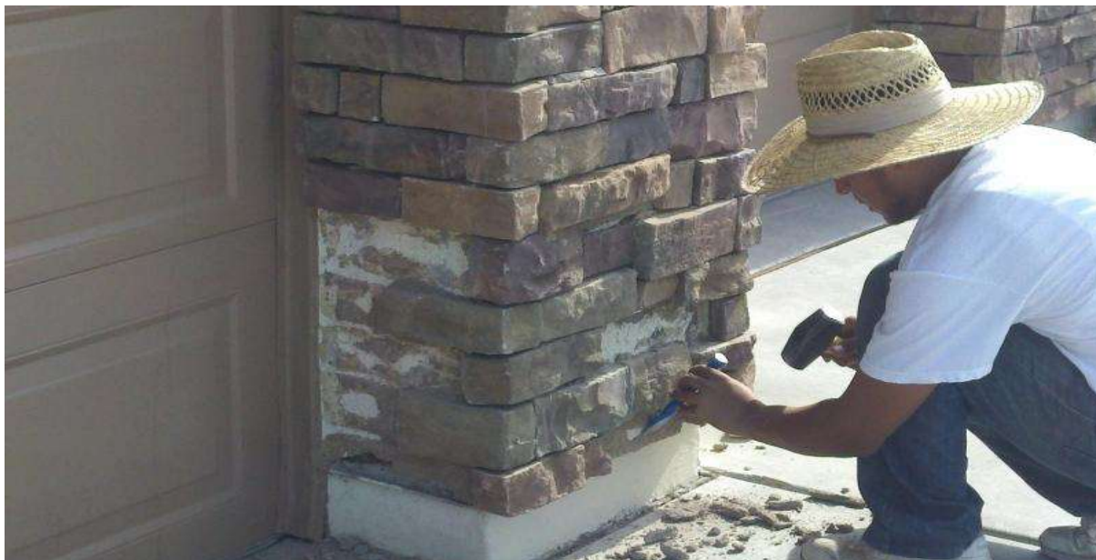
Slika 15. Skidanje labavih ploča i neodgovarajućeg veziva
