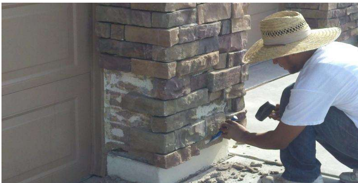
Slika 15. Skidanje labavih ploča i neodgovarajućeg veziva
