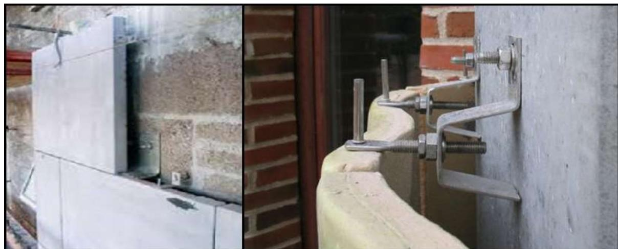
*Slika 33. Postavljanje kamenih ploča na pročelje građevine*
