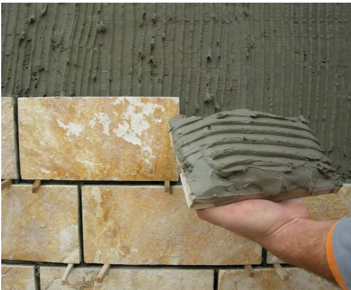
Slika 40. Oblaganje kamenim pločama
