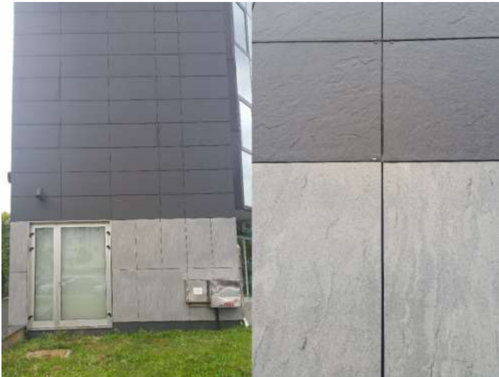
Slika 26. Ventilirajuća kamena fasada Zagrebačka banka Špansko, Zagreb
