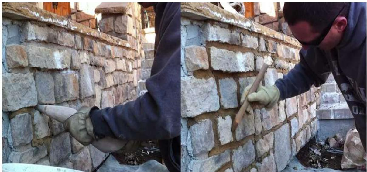
*Slika 17. Fugiranje vrećicom i ručno zaglađivanje površine*
