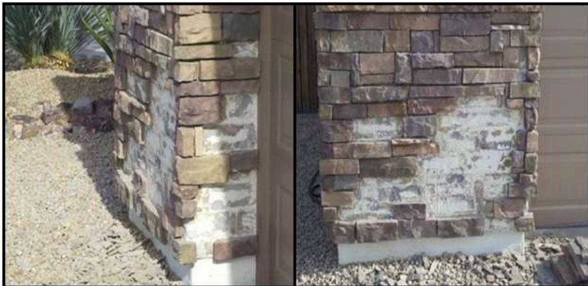
*Slika 13. Popuštanje vezivnog sredstva između kamene ploče i konstrukcije*
