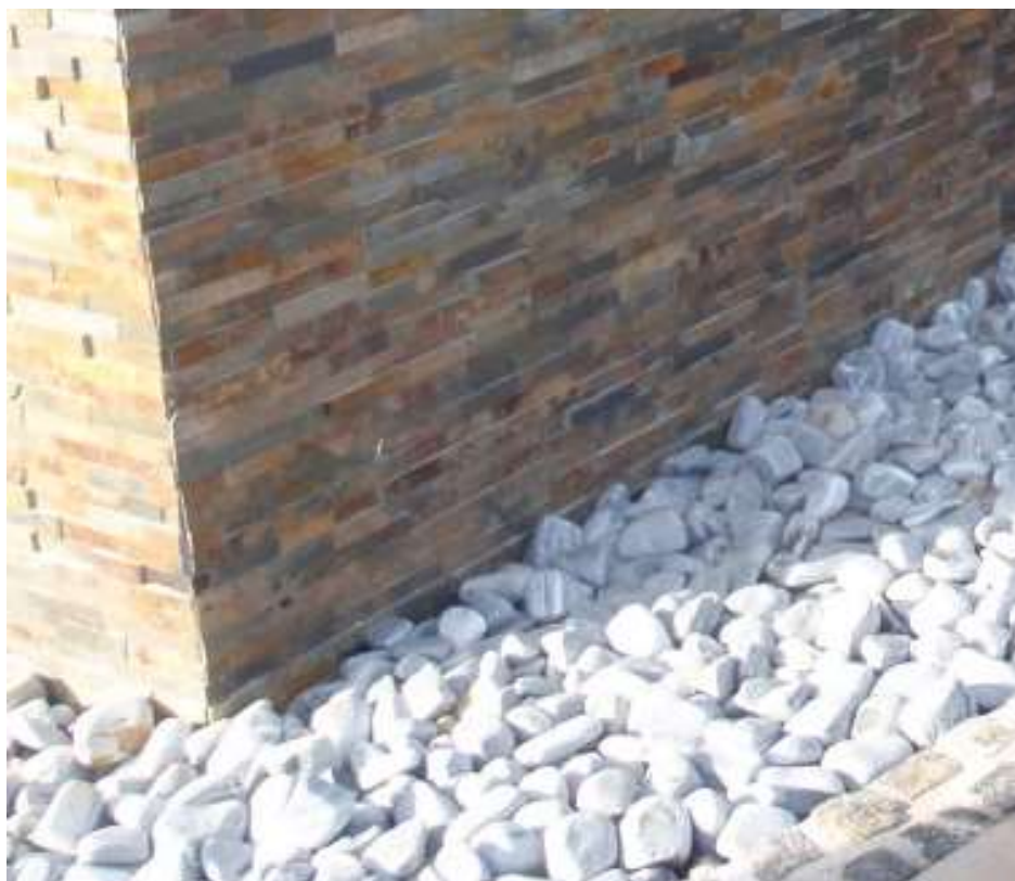
Slika 23. Drenažni sloj od oblutaka
