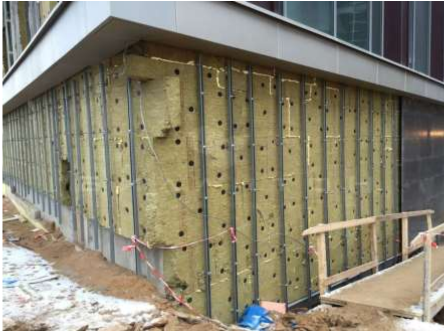
Slika 38. Postavljanje izolacije ispod ploča ventilirane kamene fasade
