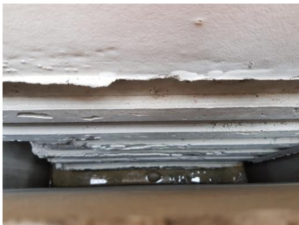
Slika 75. AB stup u temeljnoj čašici
