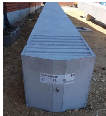
Slika 72. Donji dio AB stupa (vidljiv trn za montažu stupa)
