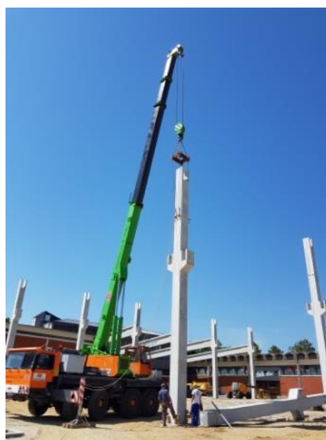
Slika 74. Postavljanje AB stupa u temeljnu čašu
