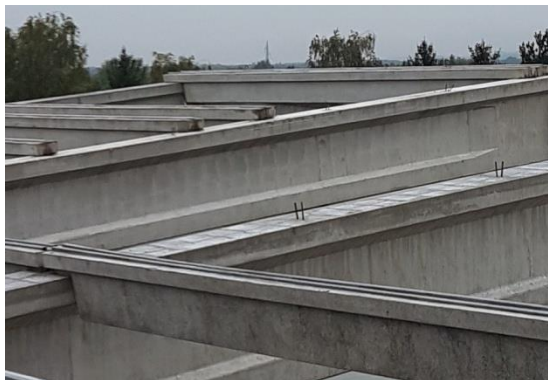
Slika 95 Montažni klinovi za sekundarne nosače
