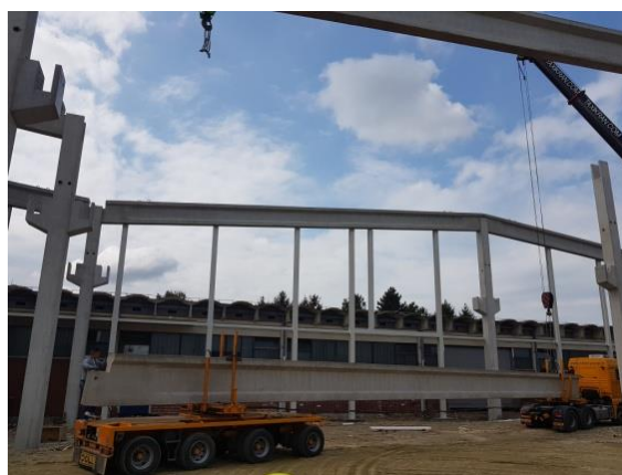
Slika 84. Priprema nosača za montiranje
