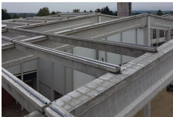
Slika 96 Montirani sekundarni nosači
