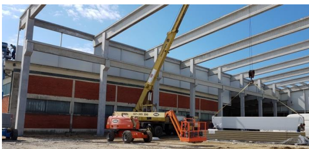
Slika 89. Montiranje zidnih panela
