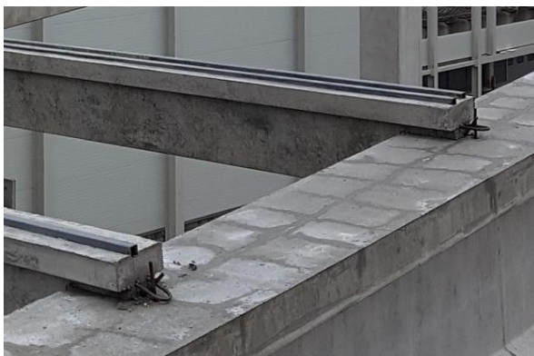
Slika 97 Vidljiv spoj sekundarnog nosača i klina
