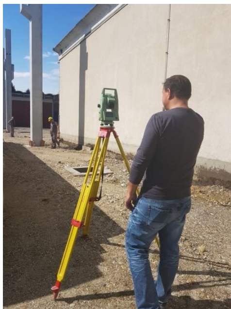
Slika 77. Određivanje vertikalnosti stupa pomoću teodolita
