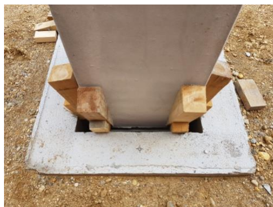
Slika 76. Centriran AB stup pomoću drvenih klinova
