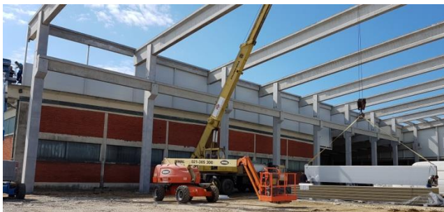
Slika 89. Montiranje zidnih panela
