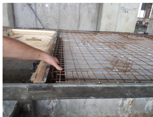
Slika 61. Armiranje AB fasadnog panela
