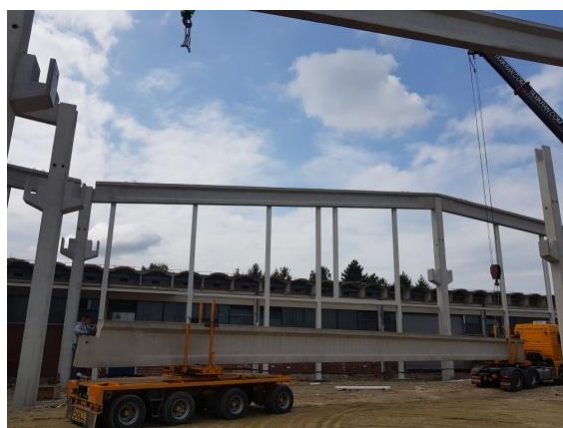
Slika 84. Priprema nosača za montiranje
