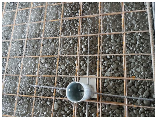
Slika 63. Pocinčana veza između slojeva fasade
