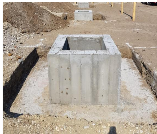
Slika 30. Prikaz gotove temeljne stope i temeljne čašice
