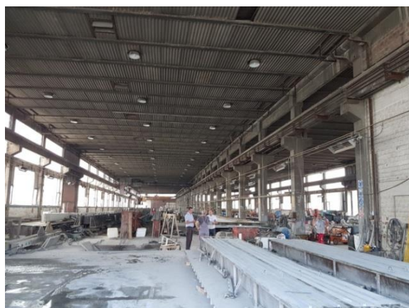
Slika 52. Hala za proizvodnju AB konstrukcija
