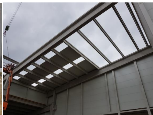
Slika 88 Montirani pokrovni panel
