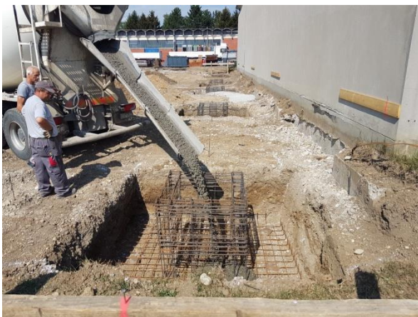
Slika 19. . Betoniranje temeljne stope
