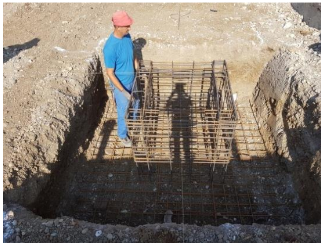
Slika 18. Centrirana armatura temeljne čašice
