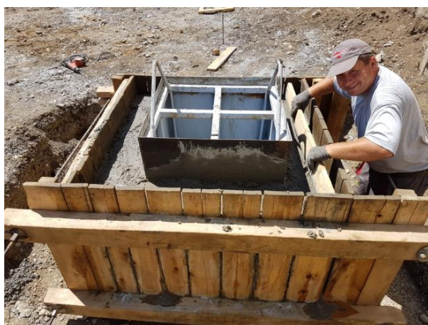
Slika 29. Ravnanje betona temeljne čašice nakon za stup betoniranja
