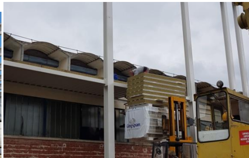
Slika 90. Montiranje nižih krovova na spoju s postojećom građevinom
