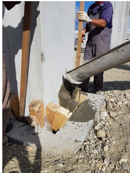
Slika 80. Zalijevanje stupova u AB čaićama sitnozrnatim betonom
