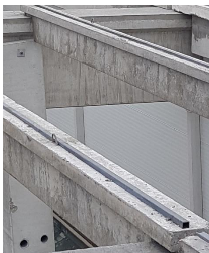
Slika 93. Montažne kuke na sekundarnom nosaču
