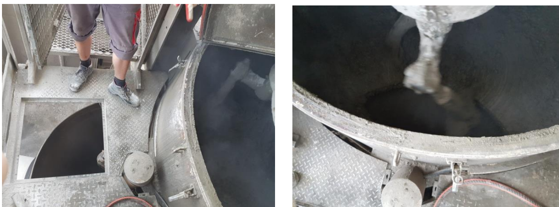
Slika 66. Miješanje betona u bubnju na betonari
