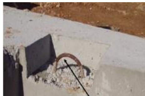
Slika 50. Pomoćna sredstva za prihvaćanje elemenata
