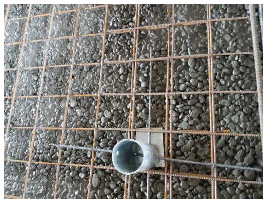
Slika 63. Pocinčana veza između slojeva fasade
