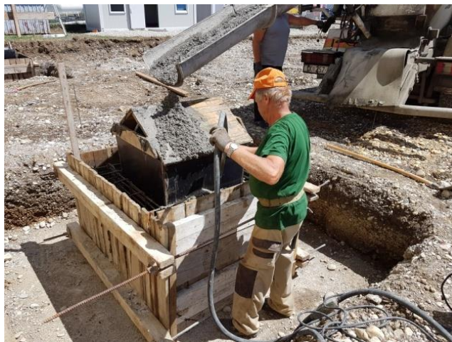
Slika 28. Vibriranje vibro iglom prilikom ugradnje betona
