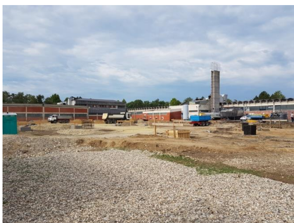
Slika 99 Gradilište na početku građenja
