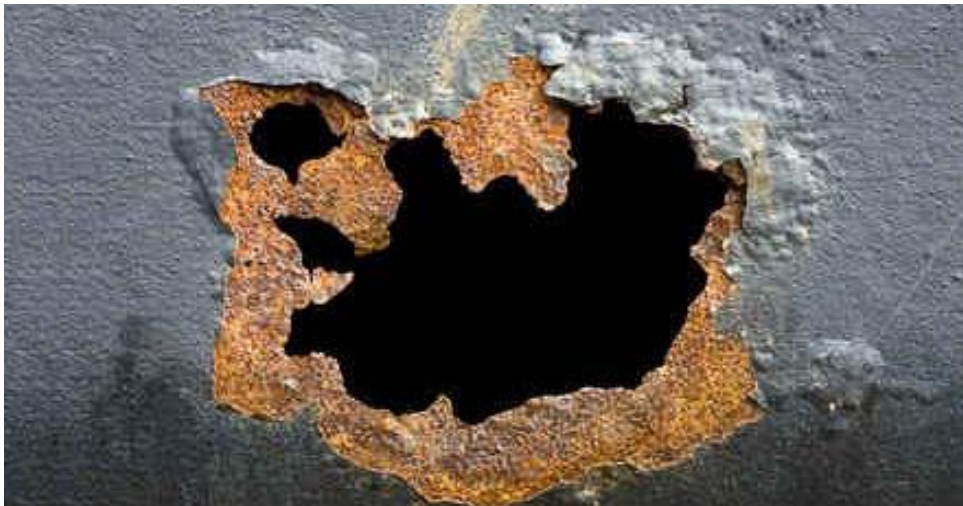
Slika 1. Pukotina nastala djelovanjem korozije na ugljičnom čeliku [13]
