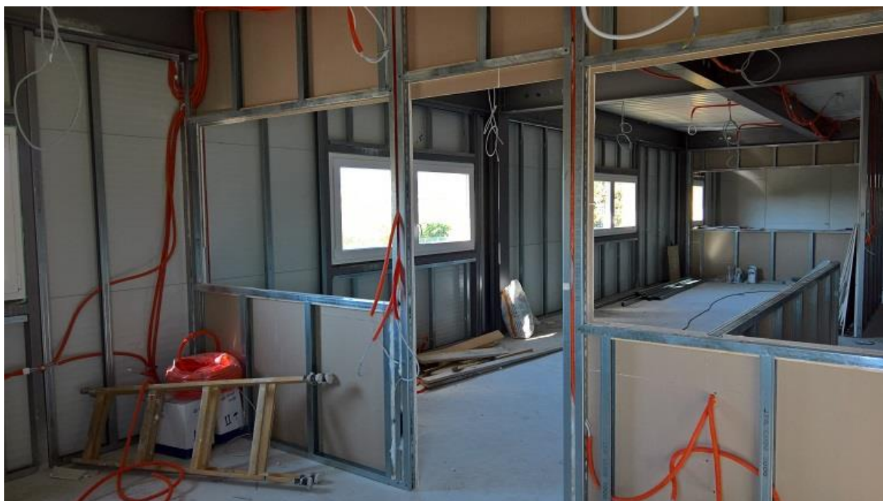
Slika 4.1. Izvedba suhomontažnih pregradnih zidova W112
