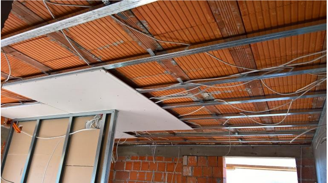
Slika 5.4. Spušteni strop izveden sa direktnim ovjesom
