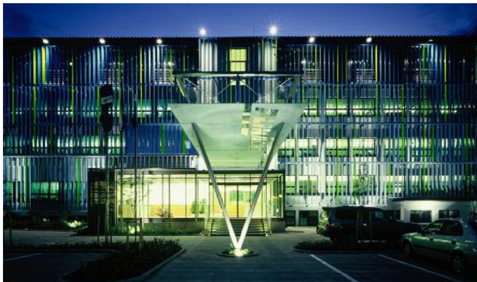
Slika 29 Upravna Zgrada Plinacra u Zagrebu Izvor: http://www.gin.hr/hr/projekti/komercijalne-poslovne-zgrade/plinacro-upravna-zgrada,12.html , pristup ostvaren 20.01.2018.
