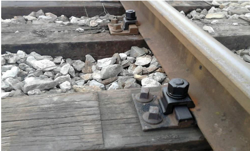
Slika 22. Drveni polovni prag ugrađen na pruzi nižeg ranga [13]
