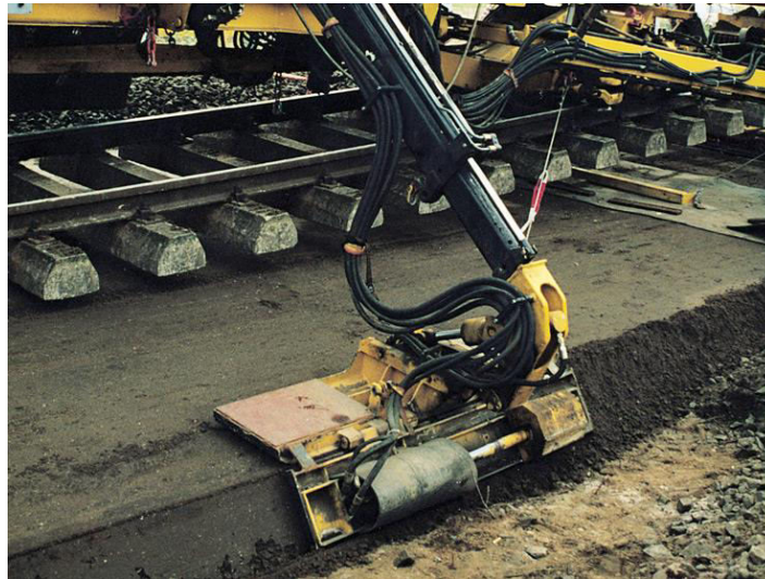
Slika 12. Završna faza uređenja novog konsolidiranog tamponskog sloja [9]
