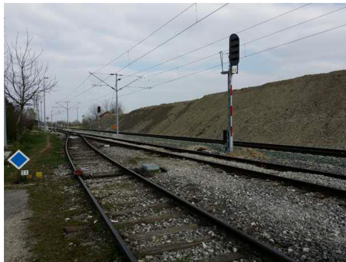
Slika 14a. Deponija kamenog agregata u kolodvoru Drnje [10]
