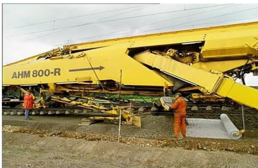
Slika 7. Stroj AHM-800 R u radu sa ugradbom geotekstila [9]
