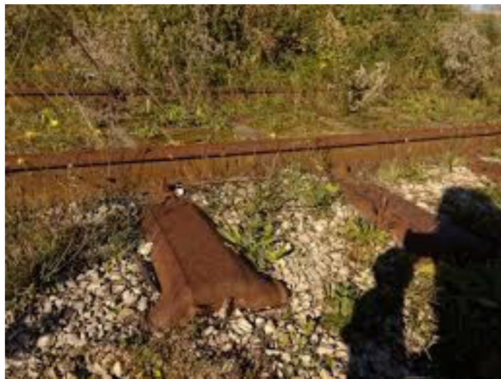
Slika broj 26. Čelični pragovi ugrađeni u kolosiječnu rešetku [16]
