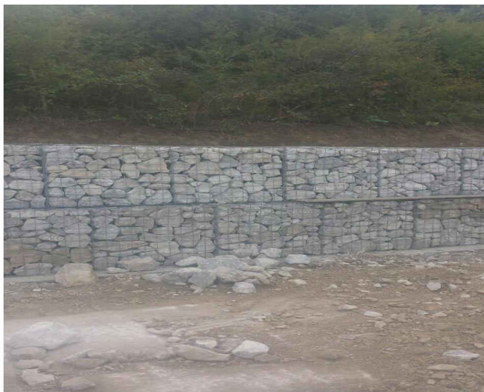
Slika 25. Izvedbeni gabionski zid iznad ceste
