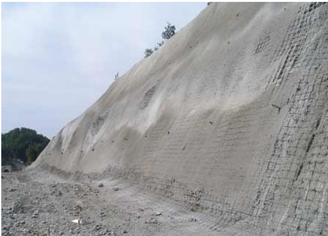
Slika 11. Primjena mlaznog betona za zaštitu kosina
