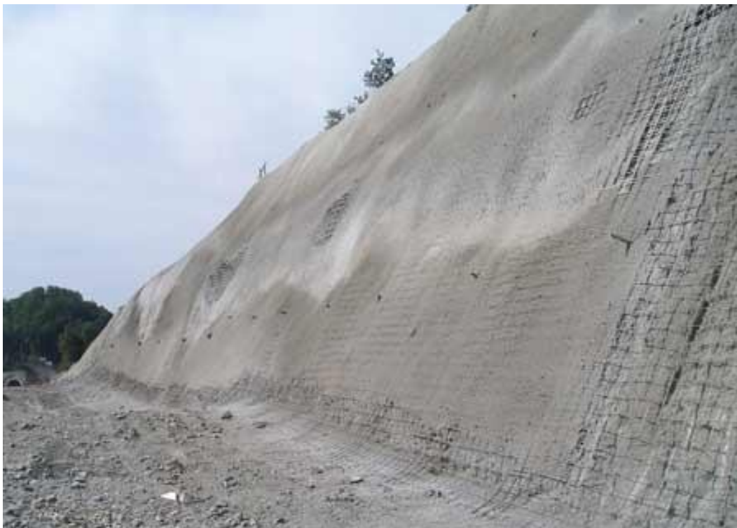
Slika 11. Primjena mlaznog betona za zaštitu kosina
