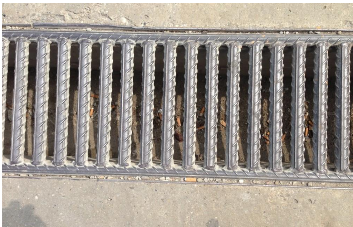
Slika 20. Linijski rešetkasti slivnik
