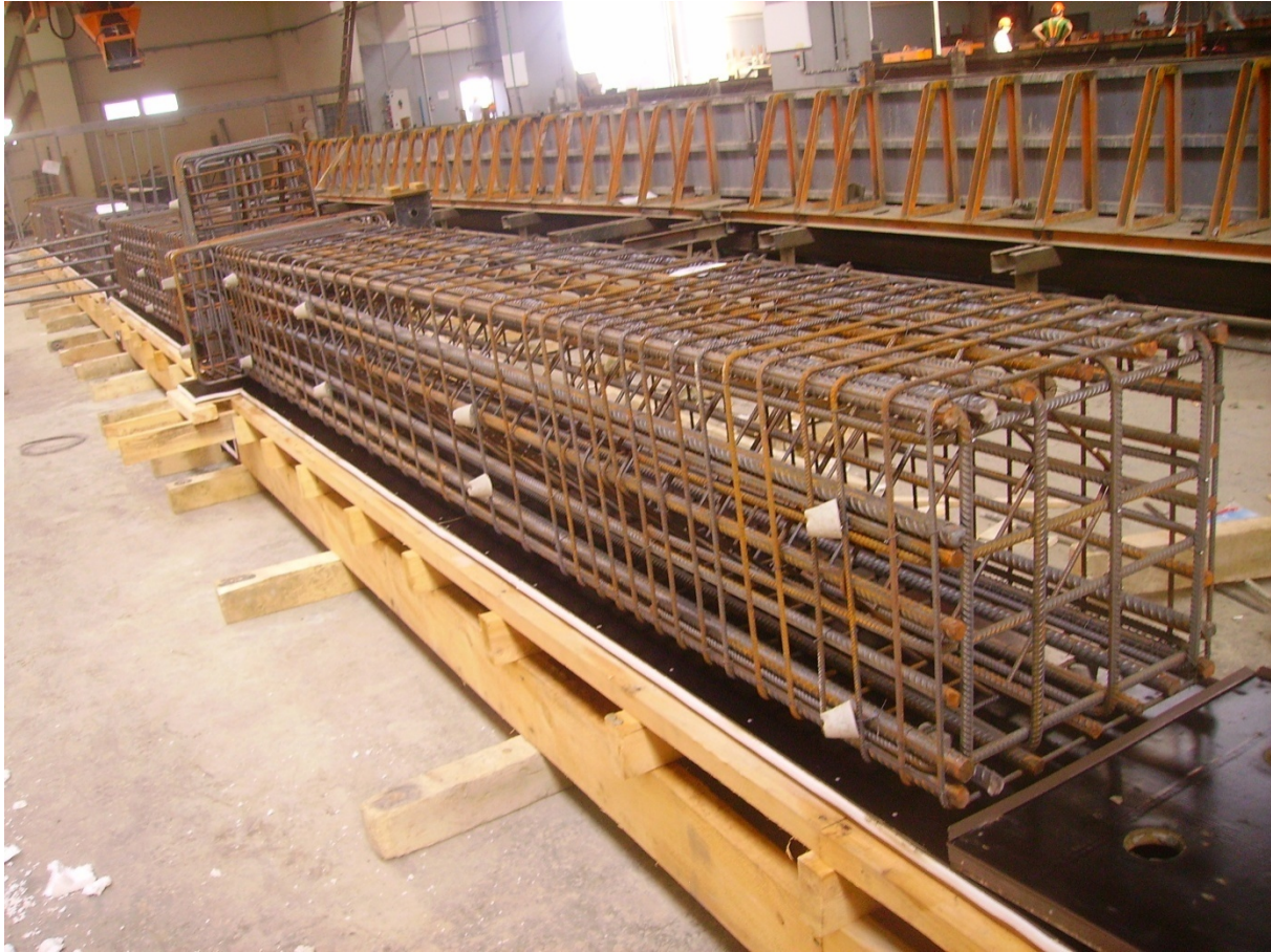
Slika 4: Armaturni koš predgotovljenog a.b. elementa - stupa za kontrolni pregled
