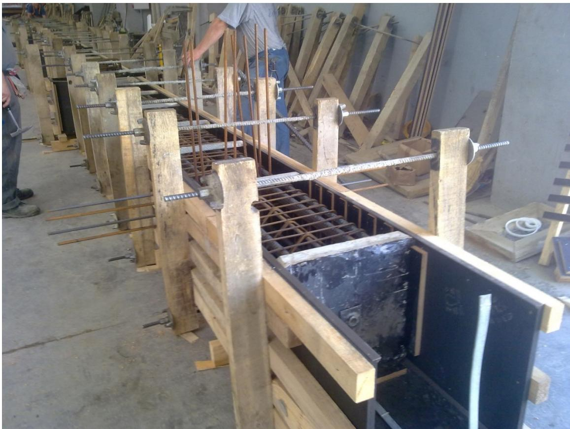
Slika 7: Provjeda mjerenja i kontrole oplate u Zagorje Tehnobetonu
