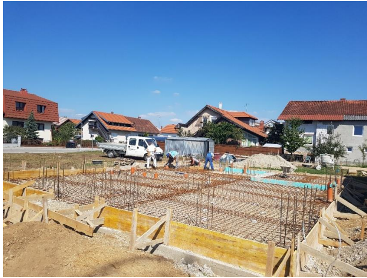
Slika 3.19. Oplata podne ploče prizemlja
