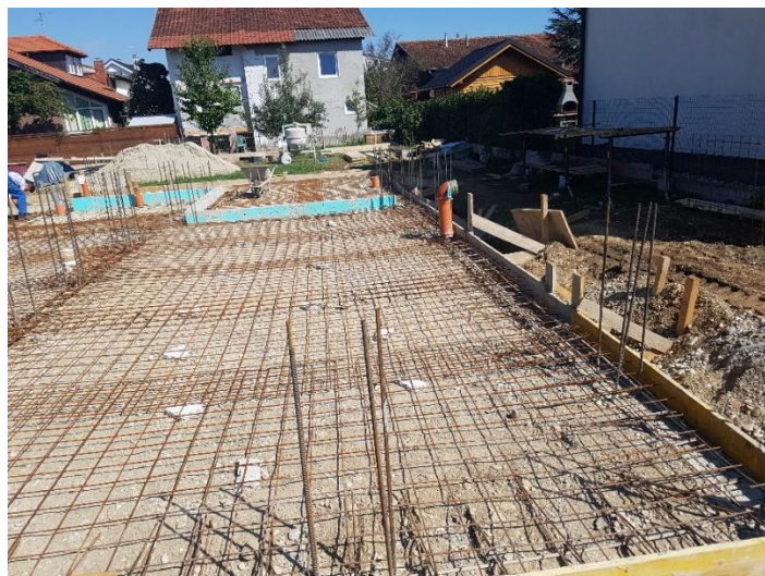
Slika 3.8. Postava armaturne mreže betonske podloge
