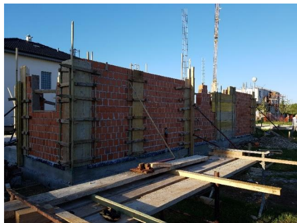
Slika 3.22. Oplata vertikalnih serklaža
