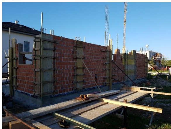
Slika 3.22. Oplata vertikalnih serklaža
