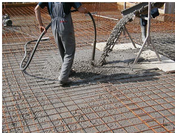
Slika 3.12. Betoniranje stropne konstrukcije
