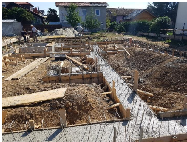
Slika 3.6. Betoniranje temelja
