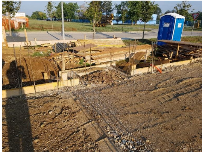
Slika 3.7. Izravnavanje podloge
