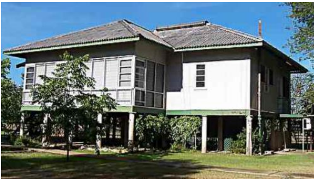
Slika 7.1. Cementna žbuka s azbestom
