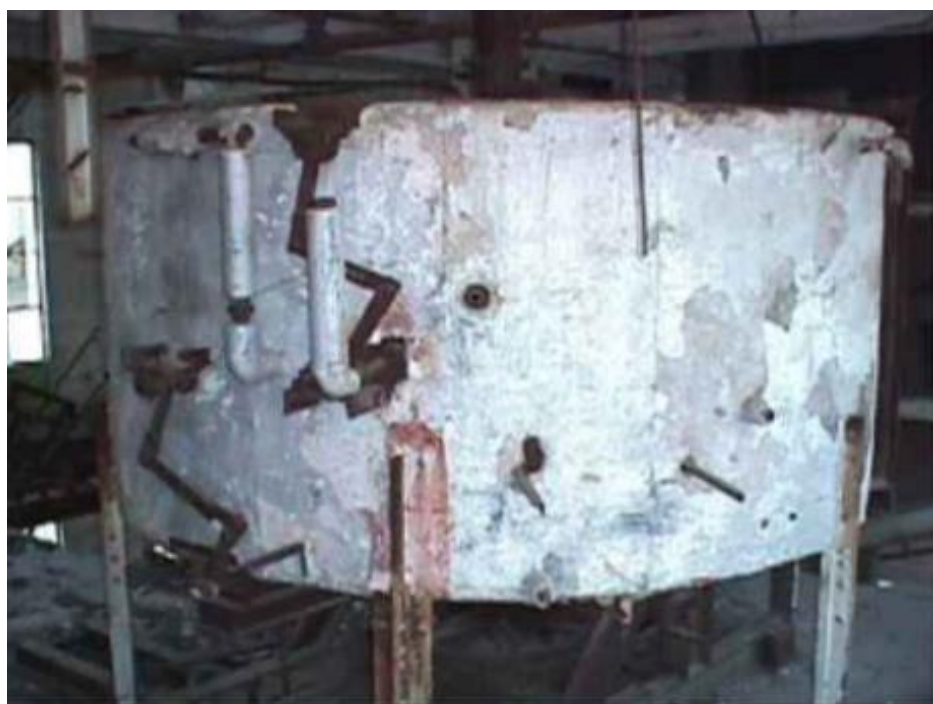
Slika 3.7. Prikaz kotla centralnog grijanja obloženog azbestom
