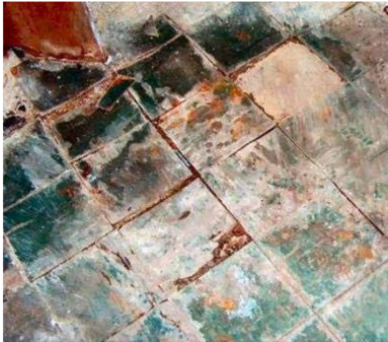
Slika 3.5. Vinil – azbestne pločice u lošem stanju
