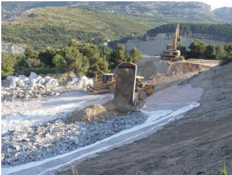
Slika 5.3. Prvi sloj zemlje preko odloženog azbestnog otpada
