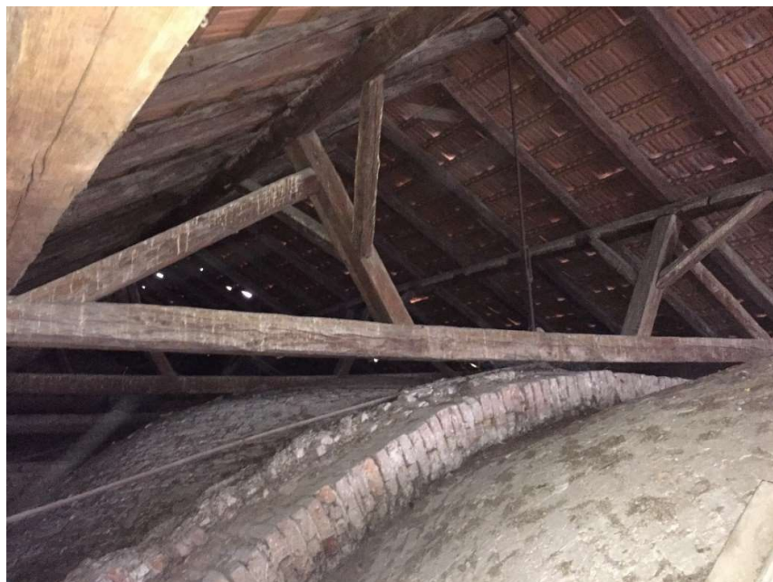
Slika 3.20. i 3.21. Pogled na krovište sinagoge i na kupolasti svod. Fotografirala: Ana Bašić
