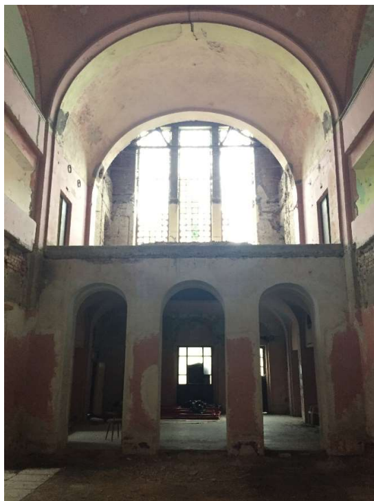
Slika 3.11. Pogled na tri jednaka ostakljena visoka otvora koji su u potpunosti izmjenili izvorni oblik sjevernog pročelja. Fotografirala: Ana Bašić
