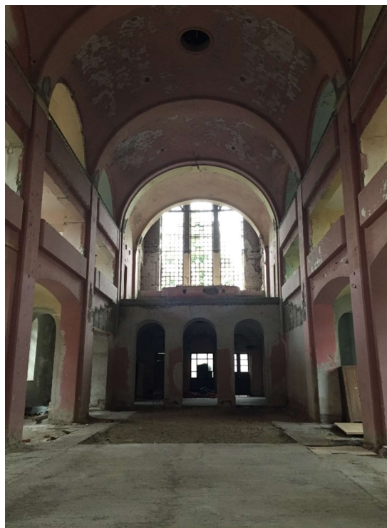
Slika 3.10. Prizemlje sinagoge s pogledom na glavna ulazna vrata sinagoge iznad kojih se nalazi foyer. Fotografirala: Ana Bašić
