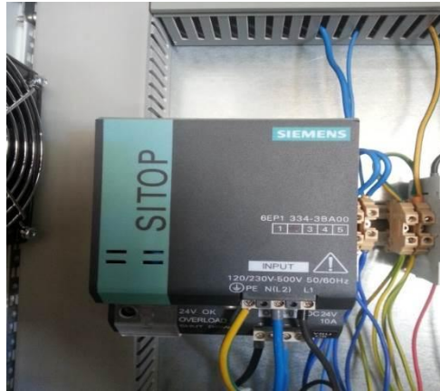
Slika 2.10. Sitop modular napajanje 24VDC [20]
