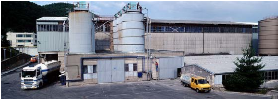
Slika 22. Dovoz i skladištenje sirovina u silose
