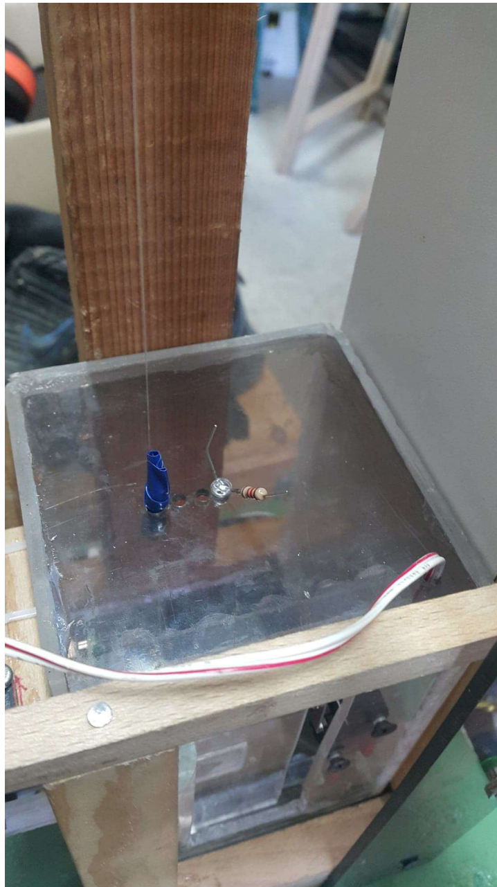
Slika 3.15. Postavljanje LED diode kao rasvjeta u dizalu
