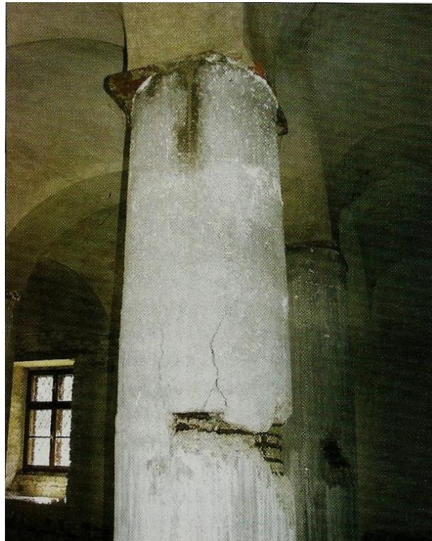
*Slika 26. Vlagom i solima nagrižen stup i zahrdana željezna armatura*
