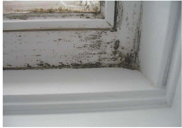
Slika 12., 13. Kondenzacija i plijesan na donjem rubu prozora
