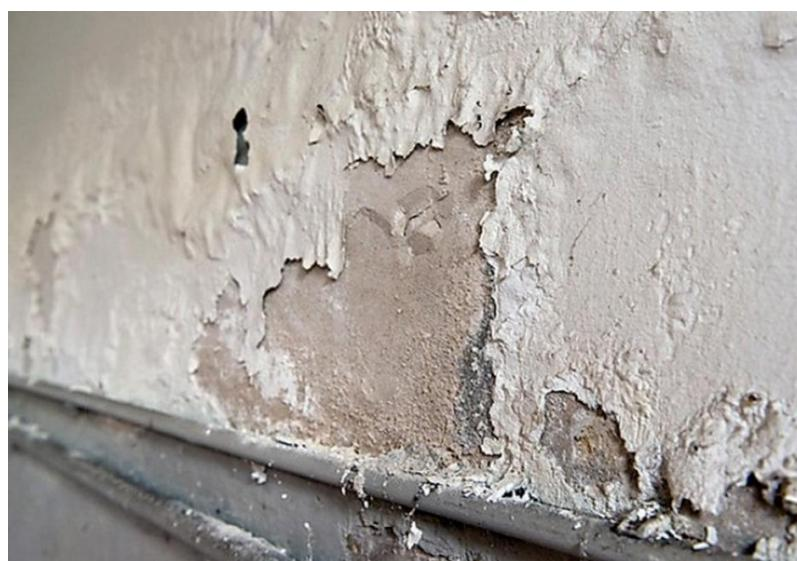
Slika 22. Oštećenje žbuke uzrokovano vlagom
