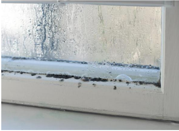
Slika 12., 13. Kondenzacija i plijesan na donjem rubu prozora
