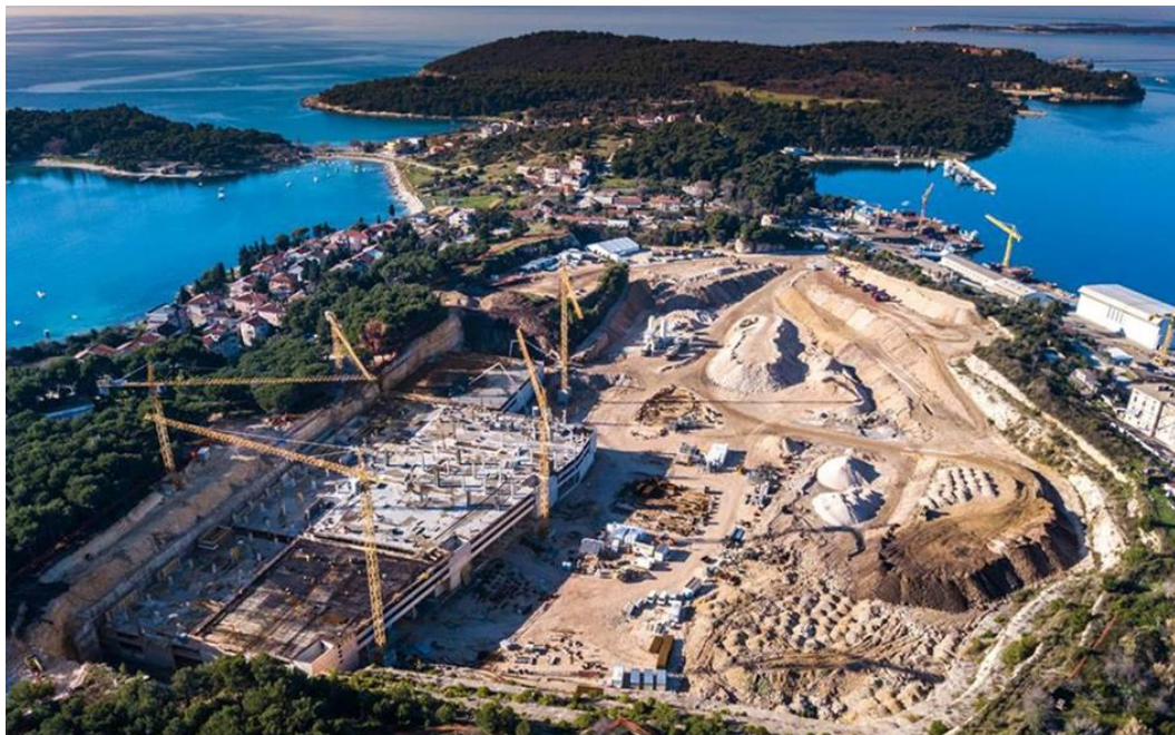
Slika 1.1 Gradilište trgovačkog centra "Max Stoja" u Puli
