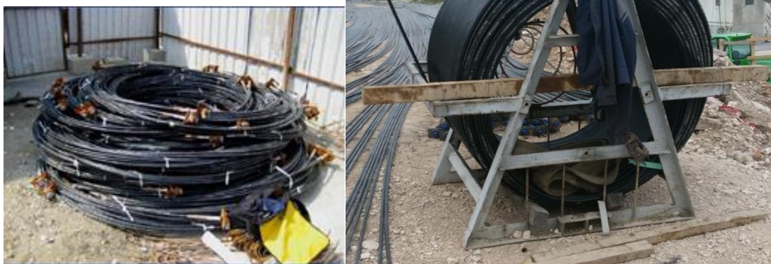
2.5 Kabeli tvornički proizvedeni u kolutima ( unbonded princip)
