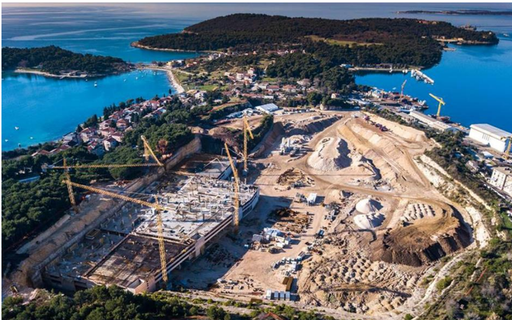
Slika 1.1 Gradilište trgovačkog centra "Max Stoja" u Puli
