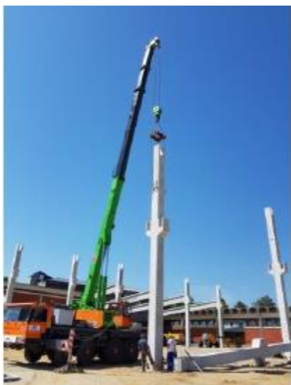
Slika 10. Postavljanje AB stupa u temeljnu čašu Slika 11. Prihvatnik na AB stupu koji se koristio kod utovara i istovara AB elementa pomoću autodizalice
