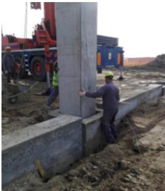
Slika 26. Postavljanje stupa u temeljnu čašu
