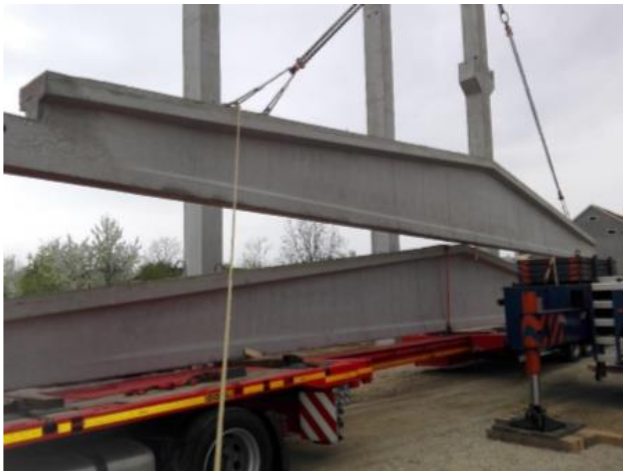
Slika 32. Doprema glavnog krovnog nosača te montiranje istog
