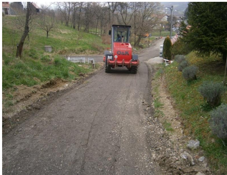
Slika 15. Ravnanje makadamskog kolnika grejderom (izvor: baza podataka Zagrebačke ceste)
