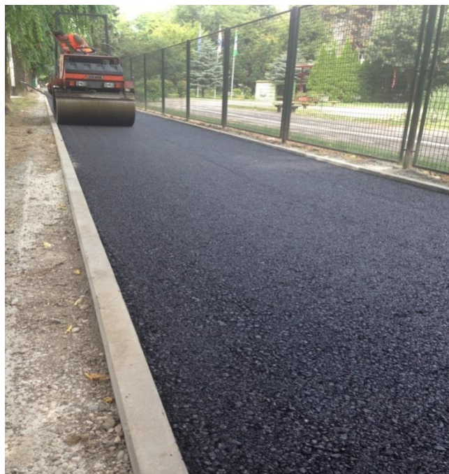
Slika 19. Ugradnja i valjanje reciklirane asfaltne mase (izvor: baza podataka Zagrebačke ceste)
