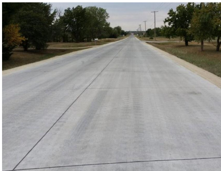
Slika 9. Klasični betonski kolnik (izvor: http://rccpavementcouncil.org )
