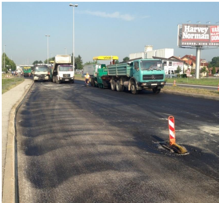
Slika 6. Poprskan bitumenski sloj za sljepljivanje asfaltnih slojeva – Zagreb Žitnjak (izvor: baza podataka Zagrebačke ceste)
