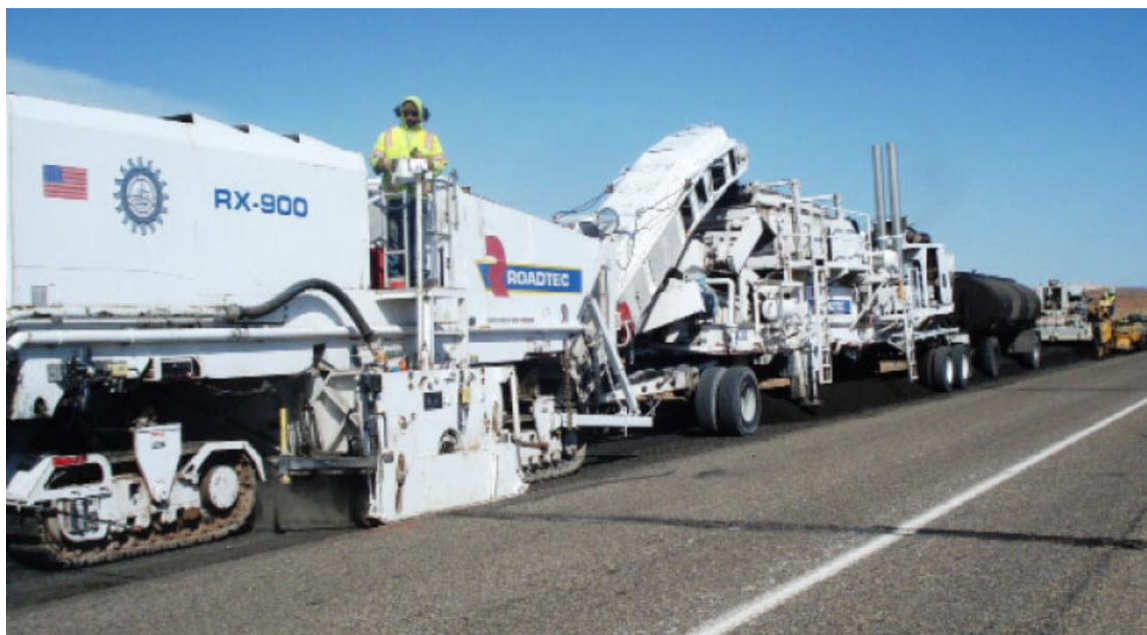
Slika 20. Kombinirani stroj za izmjenu i ugradnju asfaltne mješavine (izvor: https://www.equipmentworld.com )
