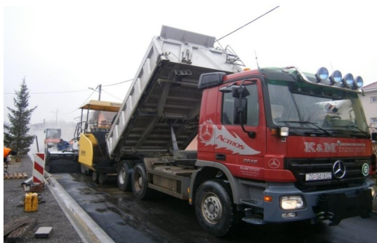
Slika 18. Strojna ugradnja reciklirane asfaltne mase finišeom (izvor: baza podataka Zagrebačke ceste)
