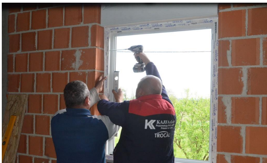
Slika 17. Ugradnja PVC prozora
