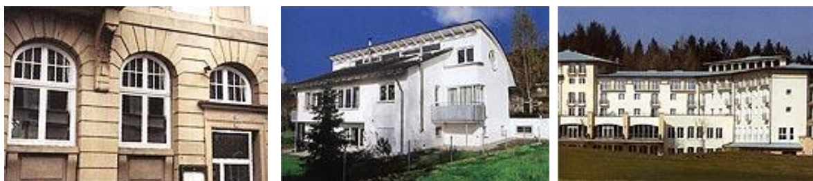
Slika 11. Primjeri ugrađenih prozorskih sustava na obiteljskim objektima
