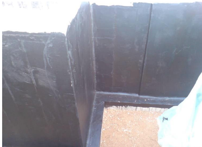
Slika 4.9. Postavljanje hidroizolacije
