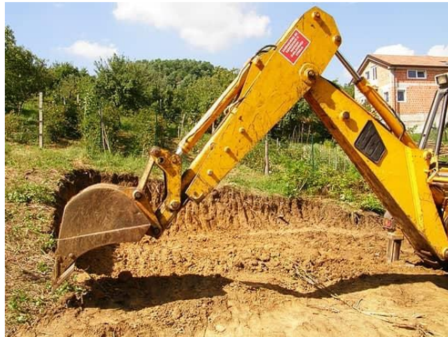
Slika 4.1. Široki iskop terena
