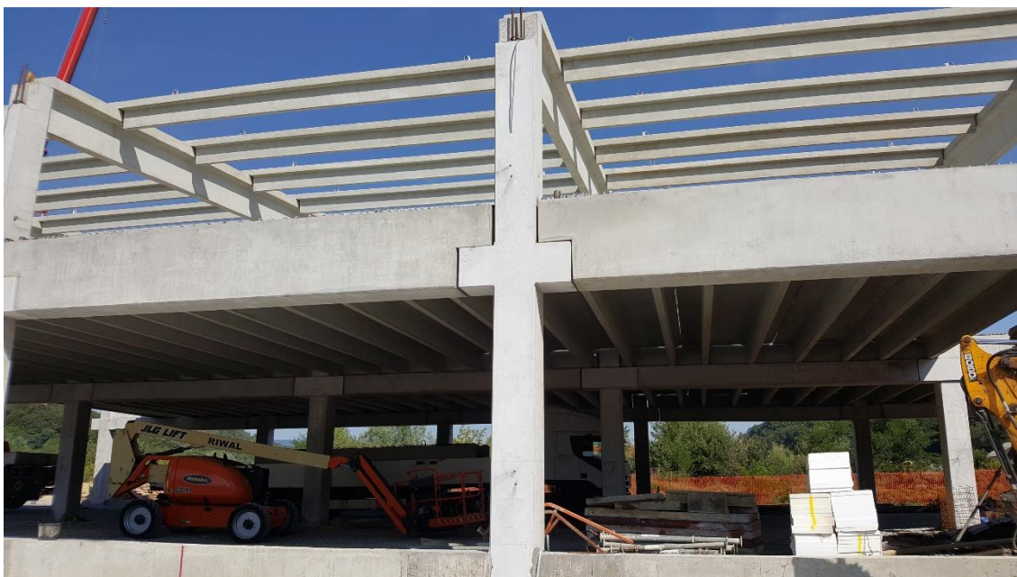
Slika 3.8. Montirani predgotovljeni elementi zgrade
