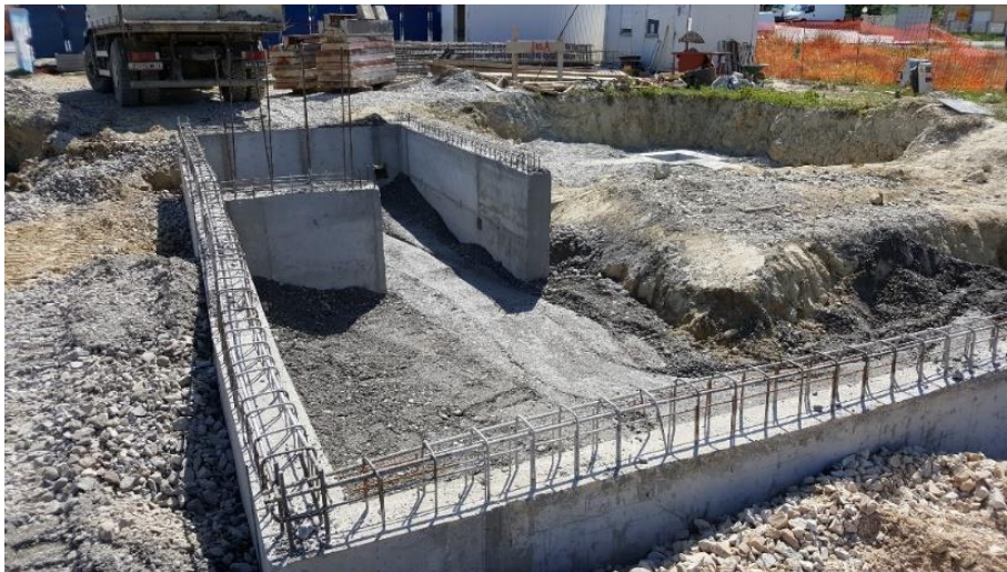
Slika 3.5. Betonirani trakasti temelj s ugrađenom armaturom
