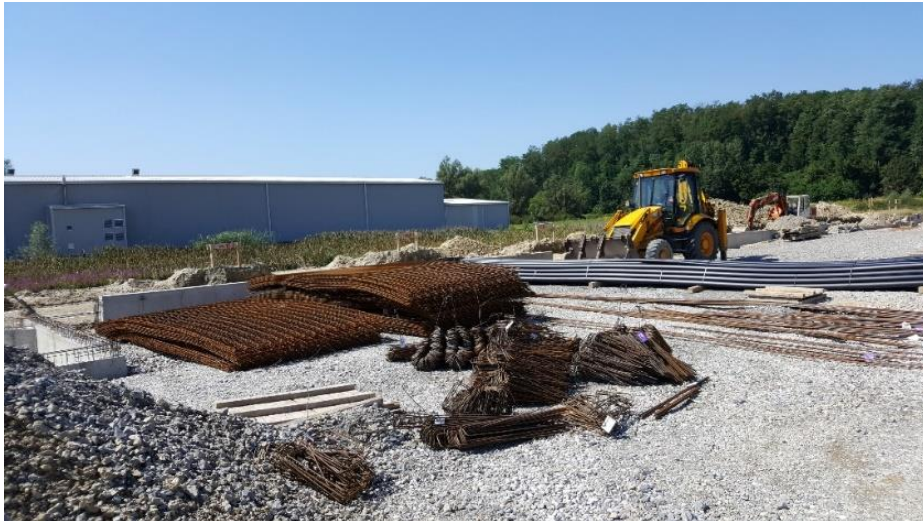
Slika 3.4. Dopremljena armatura iz armiračkog pogona
