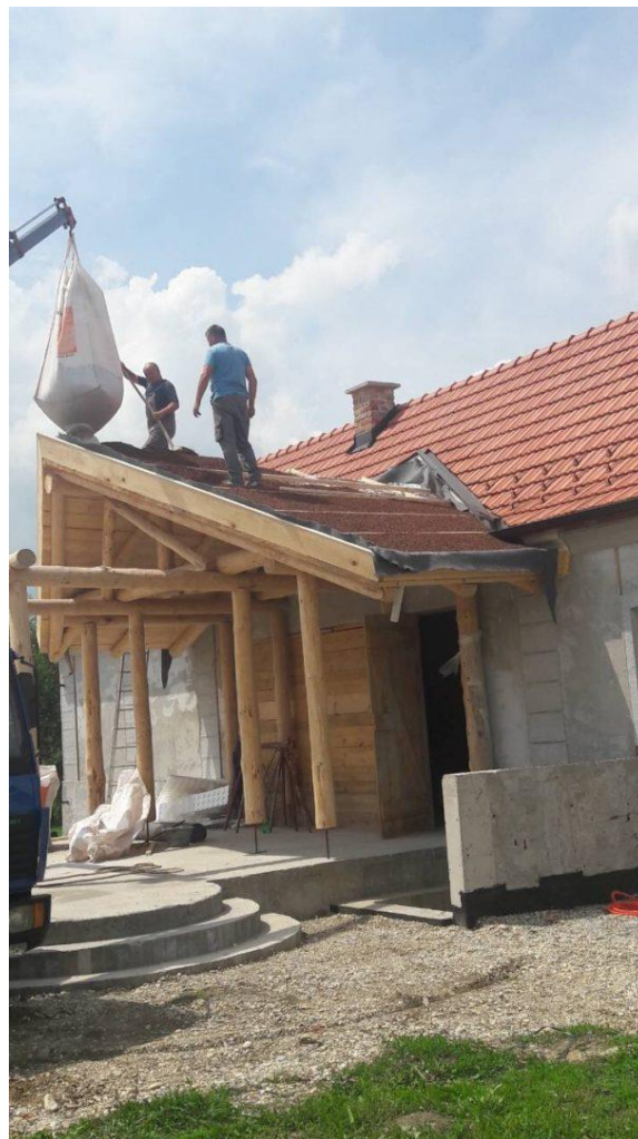
Slika 5.3. Izvedba kosog zelenog krova u Murskom Središću
