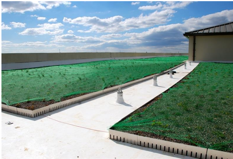
Slika 3.9. Odvajanje dijelova zelenog krova rubnim profilima
