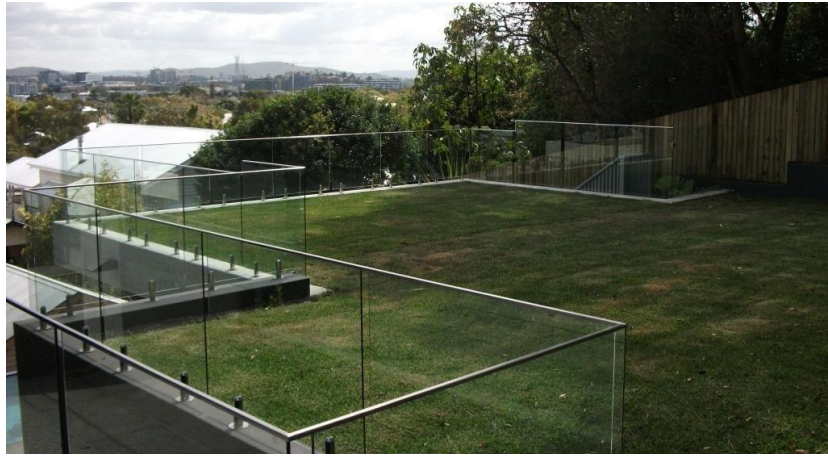
Slika 3.10. Staklena ograda na zelenom krovu
