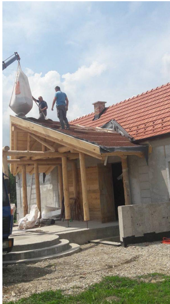
Slika 5.3. Izvedba kosog zelenog krova u Murskom Središću
