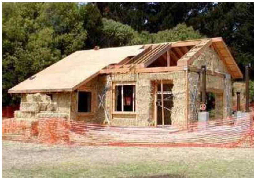
Slika 19: Gradnja kuće od bala slame
