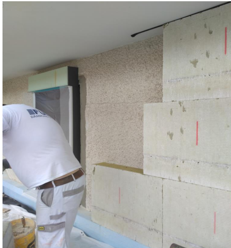
Slika 17: Postavljanje fasade od kamene vune
