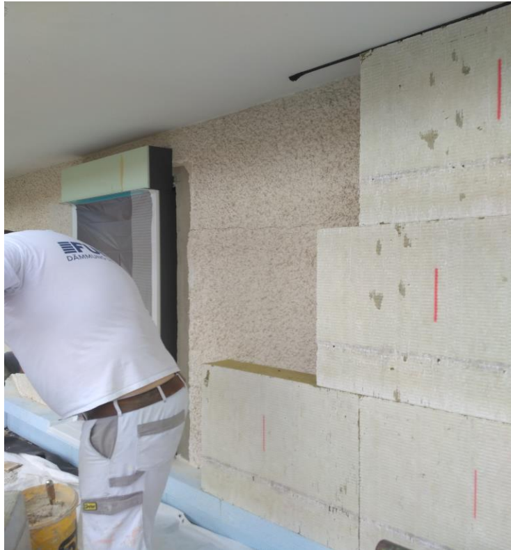
Slika 17: Postavljanje fasade od kamene vune
