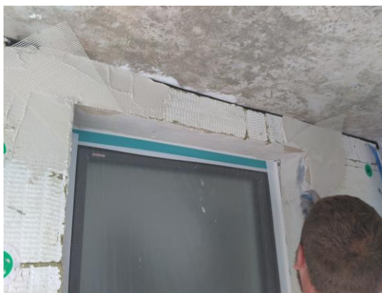
Slika 13. Postavljanje završnih profila
