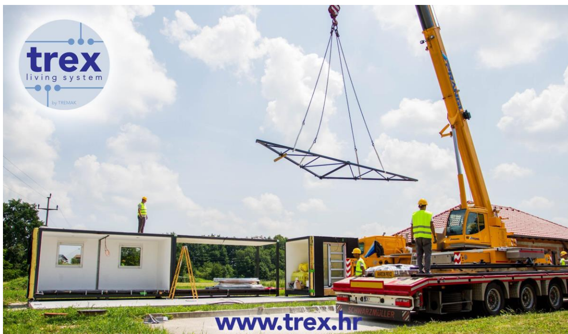
Slika 3.6. Prikaz montiranja čelične konstrukcije krova, lokacija: Slovenija
