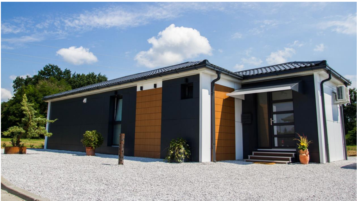
Slika 3.9. Završena Trex Family 80+ kuća, lokacija: Slovenija
