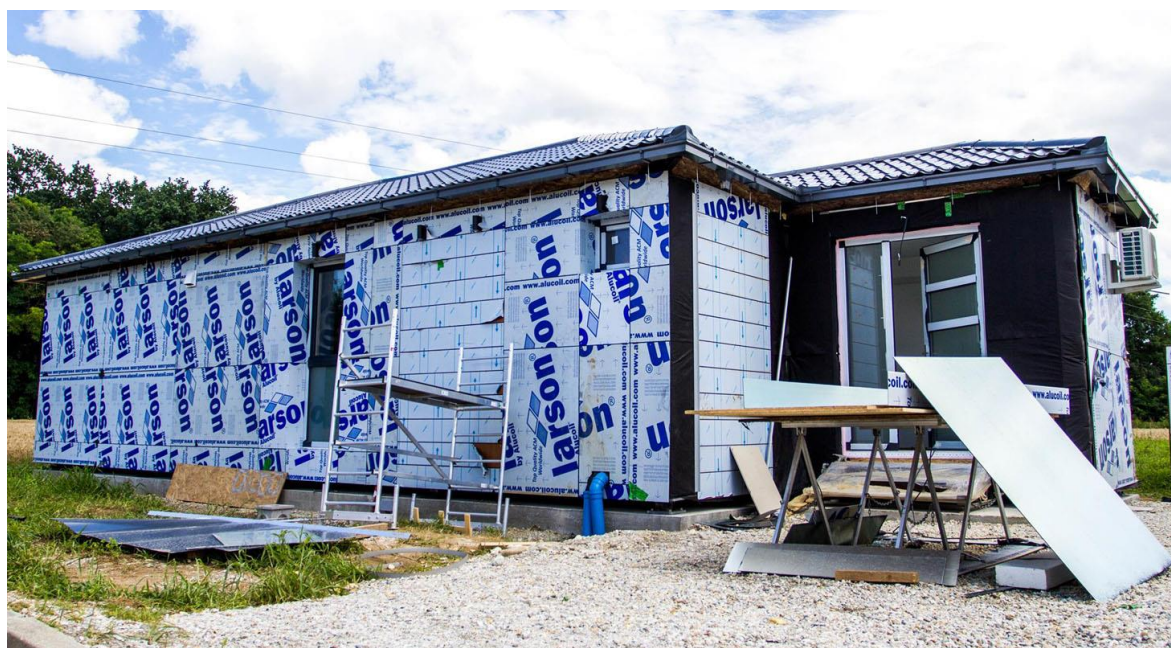
Slika 3.7. Završna ugradnja i obrada vanjskog dijela fasade, lokacija: Slovenija
