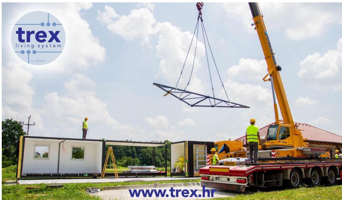
Slika 3.6. Prikaz montiranja čelične konstrukcije krova, lokacija: Slovenija
