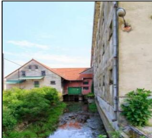
Slika 7. Postojeće stanje strojarnice izvana [21]
