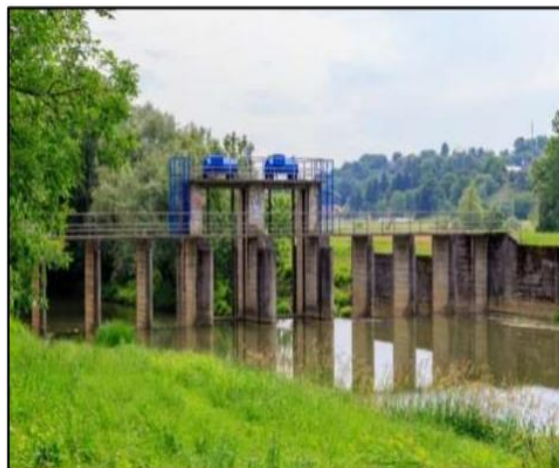
Slika 8. Brana Kućan Ludbreški [21]
